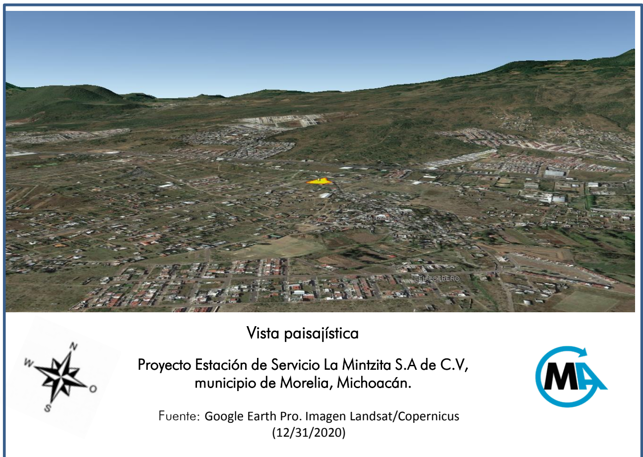
FIGURA 22. VISTA DEL PAISAJE HACIA EL NOROESTE
