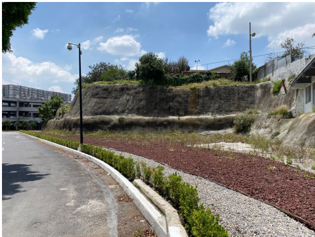
AL ESTE CON ESTACIONAMIENTO
