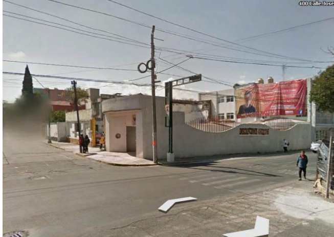
Fotografía No. 7. Evidencia de que la estación SERVICIO EXPRESS SANTA CLARA S. DE R.L. DE C.V. contara con energía eléctrica de la Comisión Federal de Electricidad.
