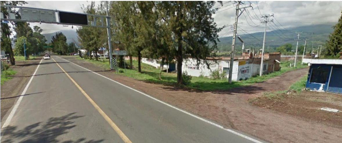
Figura 5. Predio en donde se construirá la estación de servicio vista frontal. Fuente: Consultor En la imagen se observa que se cuenta con la infraestructura eléctrica a un lado del predio.
