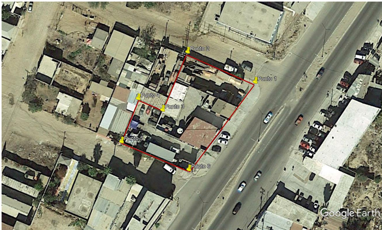
Imagen del mes de diciembre del 2020 antes de iniciar construcción
