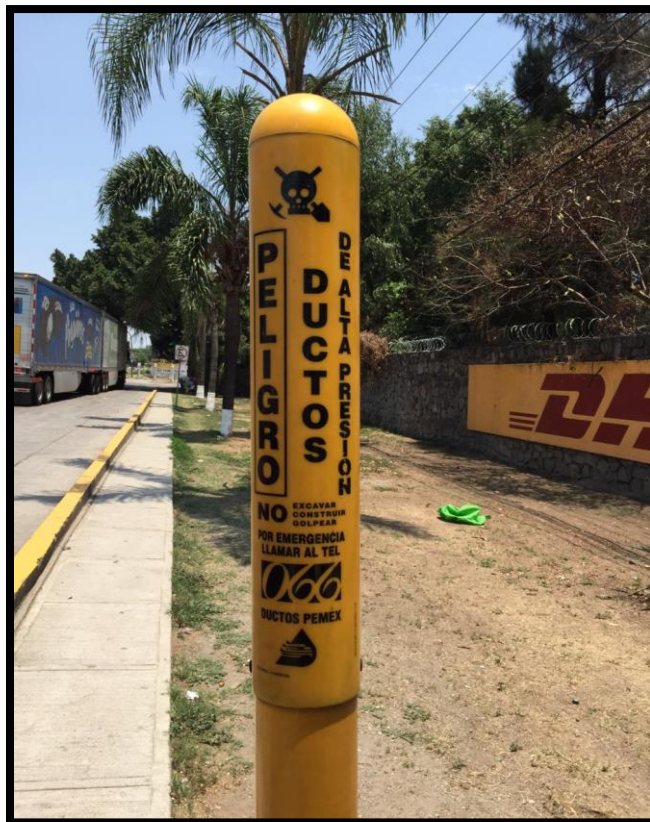
IMAGEN 18. SEÑALETICA DE GASODUCTO. FUENTE: AP CONSULTORES.
