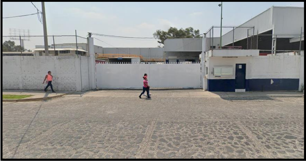
FOTOGRAFÍA 9. CEDIS GUADALAJARA A 193 METROS LINEALES APROXIMADAMENTE EN DIRECCIÓN AL SUROESTE.
