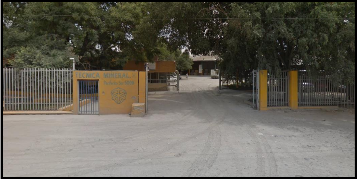
FOTOGRAFÍA 6. TÉCNICA MINERAL 171 METROS LINEALES APROXIMADAMENTE EN DIRECCIÓN AL NORESTE.
