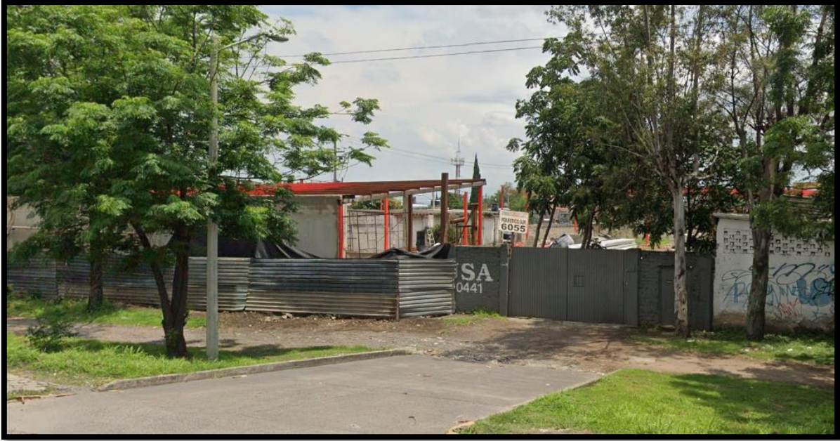
FOTOGRAFÍA 2. SERVICIOS DE ACERO A 121 METROS LINEALES APROXIMADAMENTE AL OESTE.
