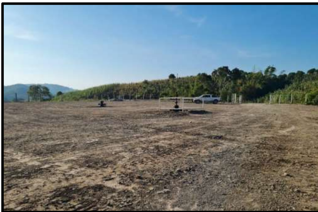
Fotografía III.4.6-6.- Plataforma existente de los pozos Miquetla-61 y Miquetla-2002, donde se pretende instalar un cabezal y dos líneas de interconexión.
