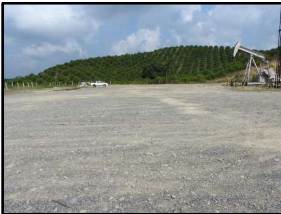
Fotografía III.4.6-5 Plataforma existente del pozo MIQUETLA-1652 donde se pretenden instalar tres líneas de interconexión.
