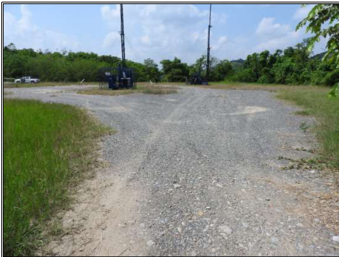
Fotografía I.1.1-2.- Plataforma de los pozos existente MIQUETLA 124 y MIQUETLA 553, vista desde el acceso a la plataforma.
