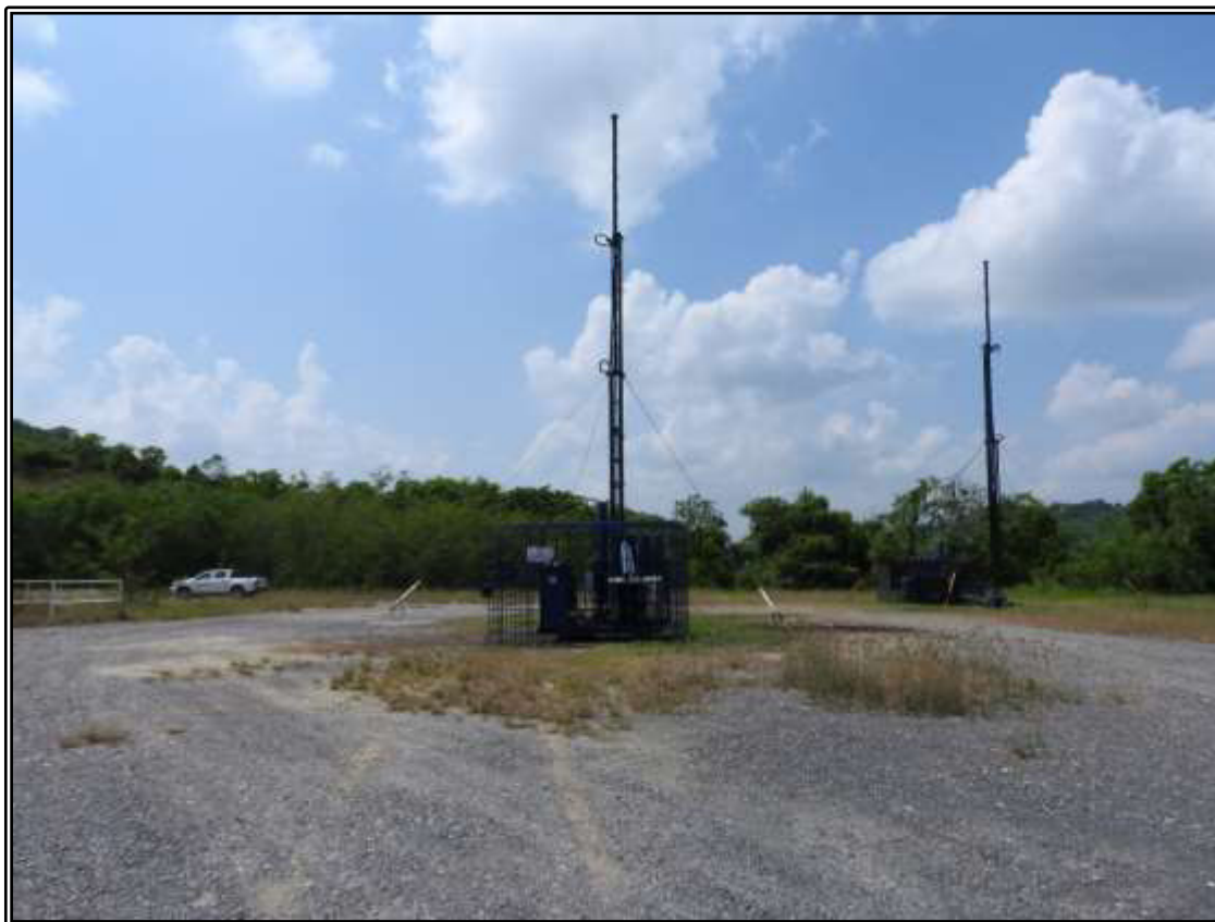
Fotografía I.1.1-1.- Plataforma existente de los pozos MIQUETLA 124 y MIQUETLA 553 donde se pretende realizar la perforación del Pozo MIQUETLA 2003
