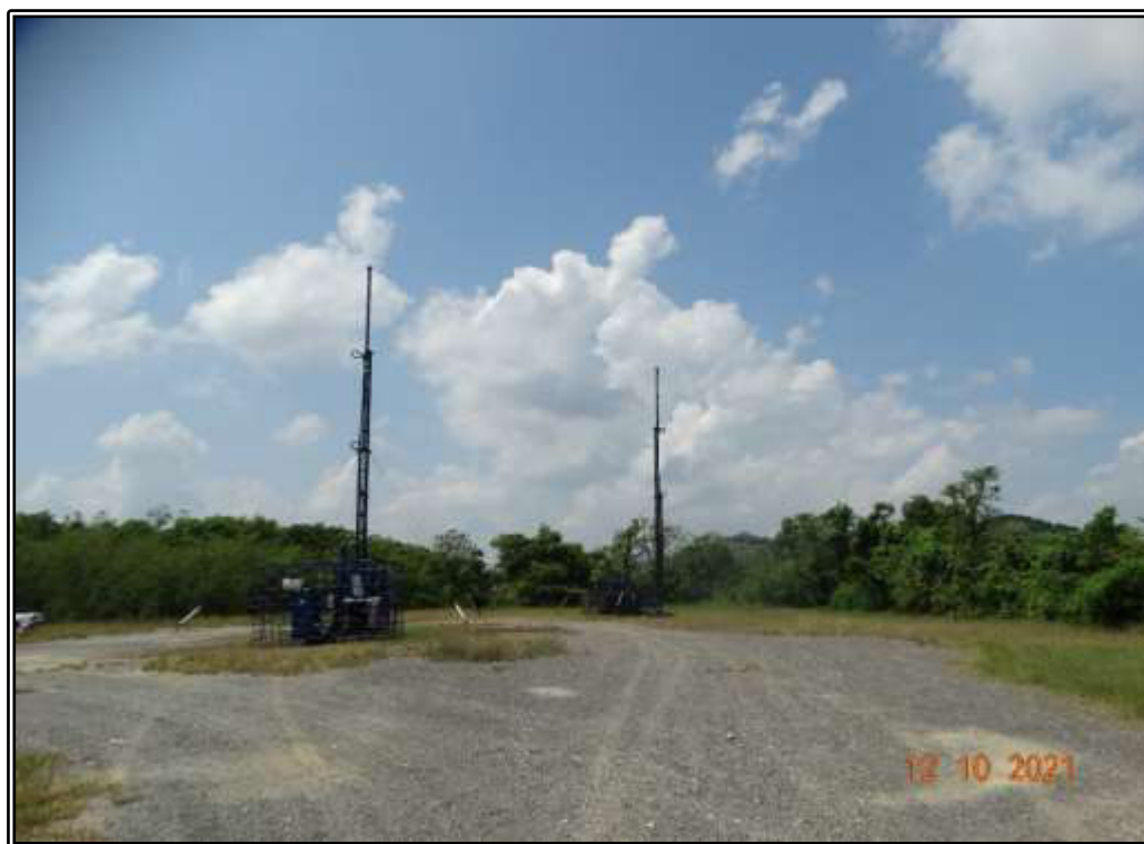
Fotografía III.4.6-5.- Plataforma existente de los pozos MIQUETLA-553 y MIQUETLA-124.
