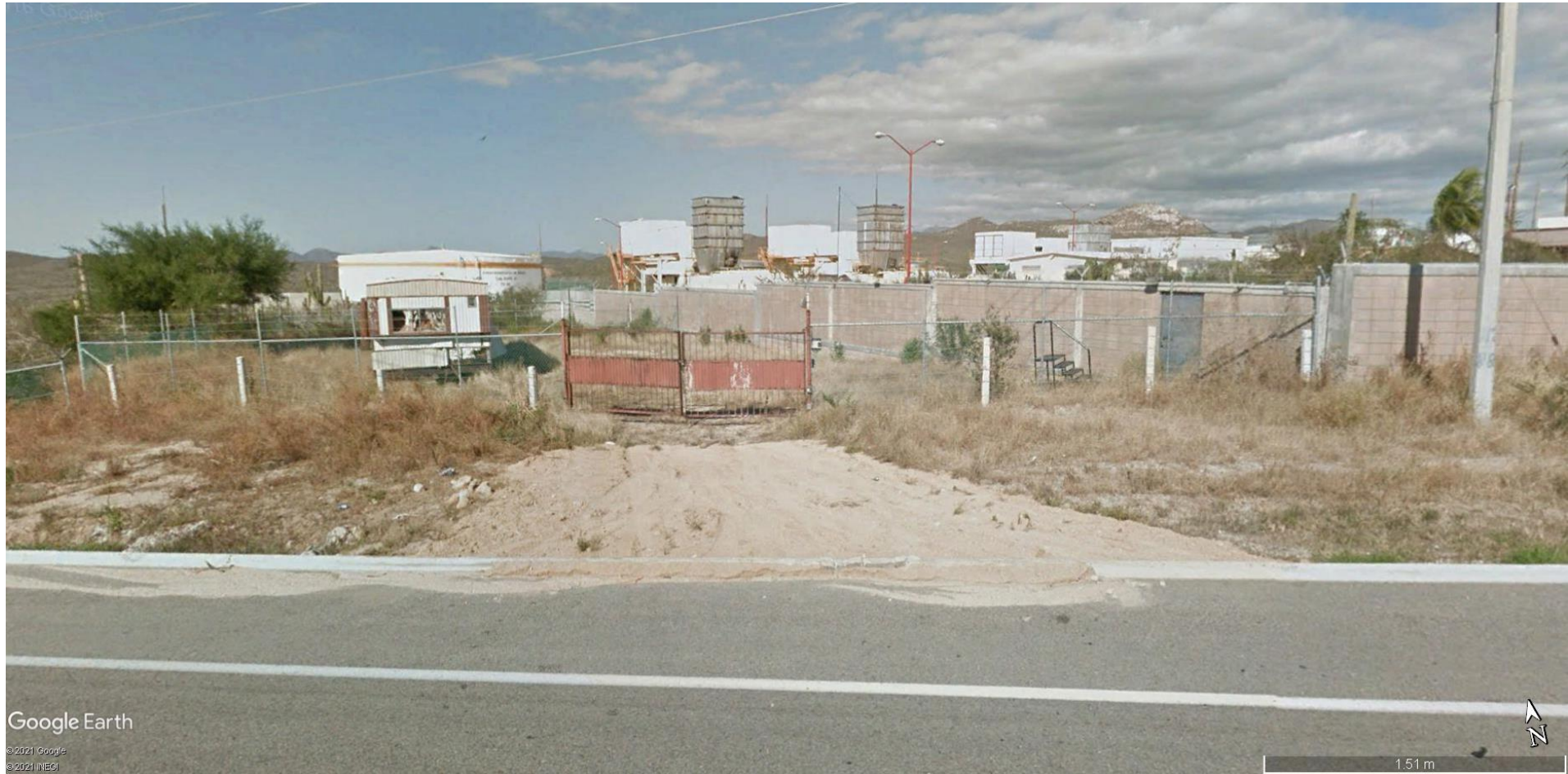
PANORÁMICA DE LA CENTRAL TURBOGAS LOS CABOS, SE APRECIA TANQUE DE COMBUSTIBLE. (VISTA DESDE LA CARRETERA CABO SAN LUCAS – TODOS LOS SANTOS)
