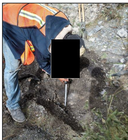
12. En el sitio se observa la presencia de roca madre a poca profundidad.
