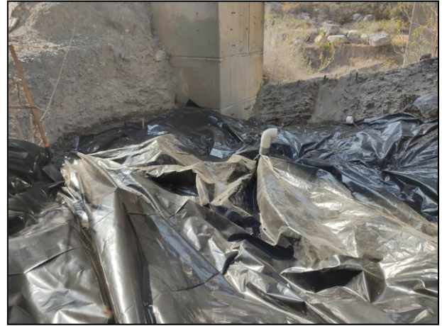
18. Toda el Área Afectada fue sometida a labores de emergencia, con la finalidad de evitar la transferencia suelo – atmósfera.
