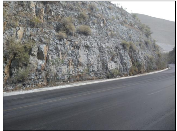
4. La Gasolina derramada se desplazó a través de la canaleta de concreto encontrada contigua a la superficie de rodamiento.
