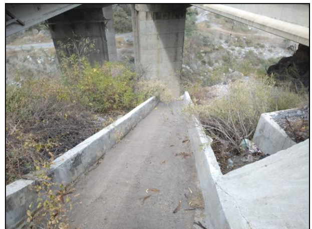
6. La Gasolina desembocó a un barranco estructurado de roca madre, con altura aproximada de 50 m.
