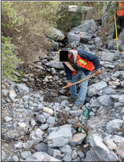
13. Presencia de abundantes rocas en el Área Afectada.
