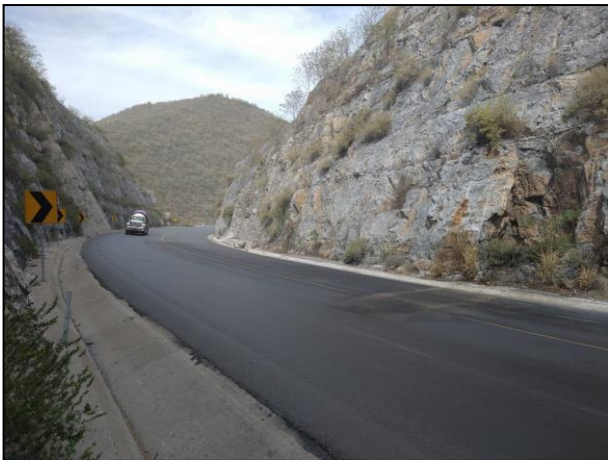
19. Canaletas de concreto encontradas contiguas a la carretera.
