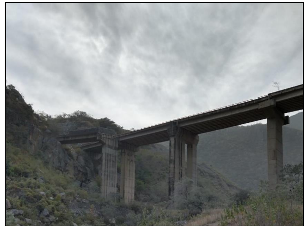
20. El área de suelo natural afectado por la Gasolina, se encuentra debajo de un puente de concreto.
