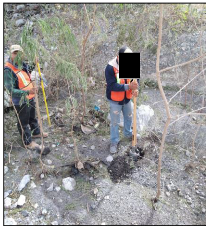
10. Se realizaron pozos de sondeo con apoyo de una pocera y recurso humano.
