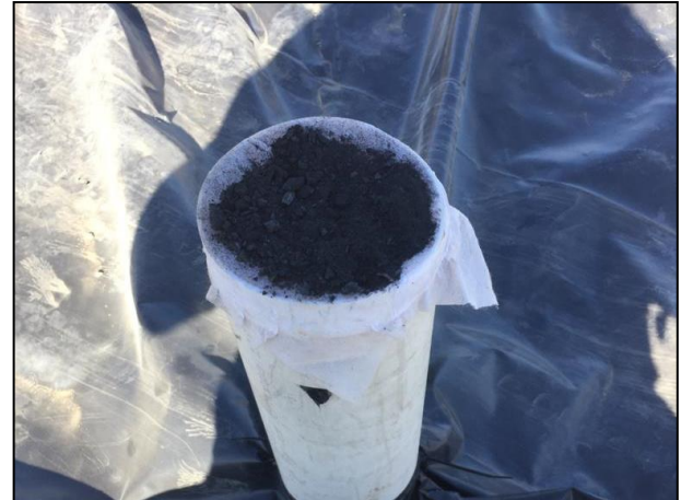
04. Seguidamente se procedió con la colocación de los filtros de carbón activado.
