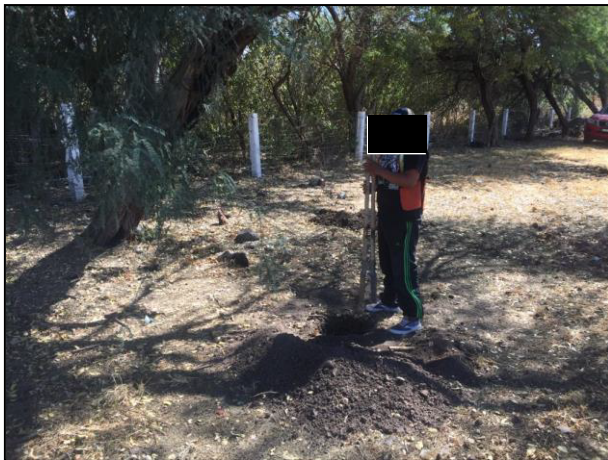
03. Utilizando pocera, se realizaron sondeos en el sitio de estudio para delimitar el área y volumen afectados por el derrame de Gasolina.
