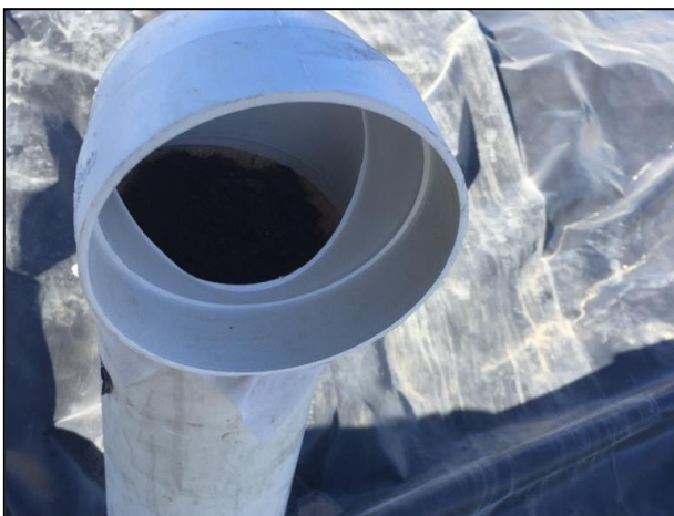
05. Colocación de filtros de carbón activado para captación de vapores.
