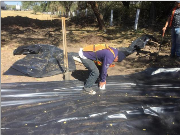
03. Toda el área afectada fue sometida a labores de emergencia, cubriendo la misma con película de polietileno de alta densidad.
