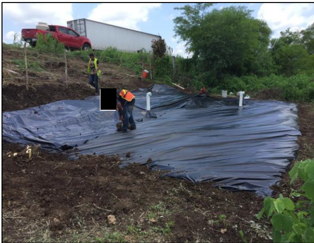
8 - Área Afectada sometida a labores de emergencia.
