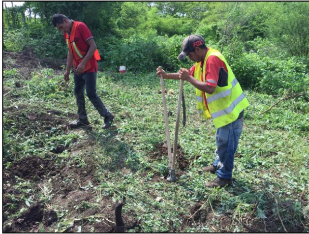
7 – Realización de pozos de sondeo.
