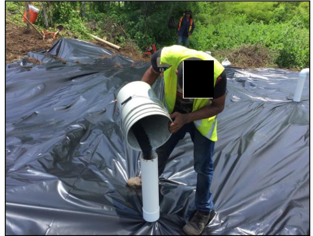
7 - Preparación de los filtros de carbón activado.
