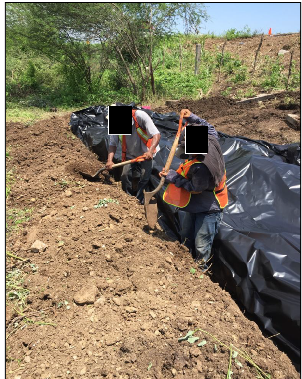
5 - Colocación de película de polietileno de alta densidad en la barrera de contención.
