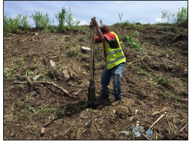
2 – Uno de los tanques que transportaba la unidad cayó a un predio particular, debido a la pendiente que posee el talud de la carretera.
