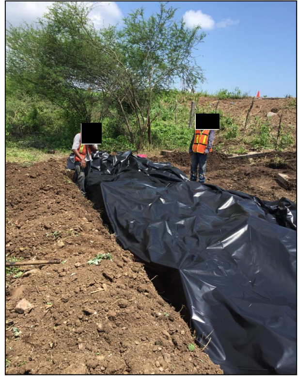
4 - Se colocó una película de polietileno de alta densidad sobre el corte realizado en la periferia del Área Afectada.
