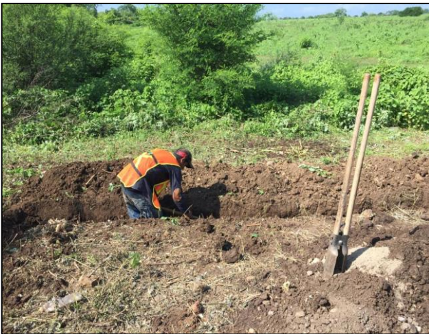
2 - Personal de campo, equipado con palas y picos, procedió a realizar una zanja en los perímetros del Área Afectada.
