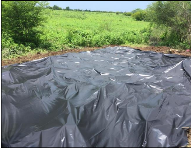
6 - En toda el Área Afectada se extendió la película de polietileno para evitar la posible transferencia de contaminantes a la atmósfera.
