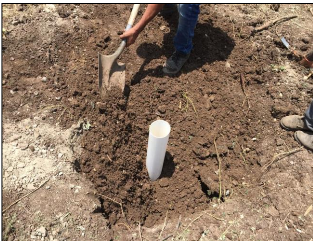
3 - Seguidamente se colocaron tubos de PVC en el Área Afectada, para instalar los filtros de carbón activado.
