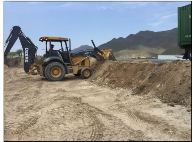
04 - Compactación de los bordos perimetrales.
