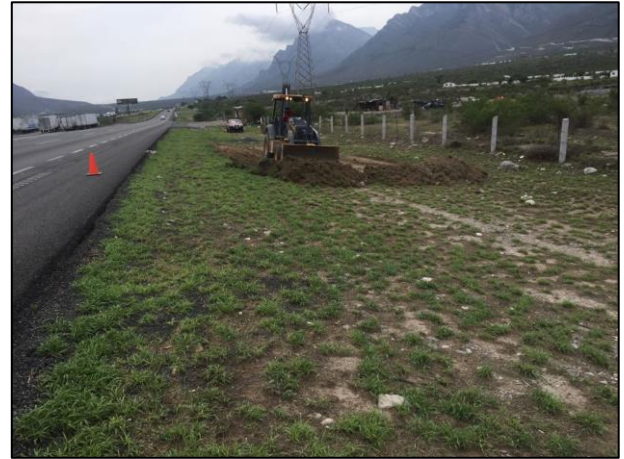
02 - Con ayuda de maquinaria pesada como lo es la retroexcavadora, se dio el acondicionamiento al sitio designado para la construcción de la Celda Provisional.
