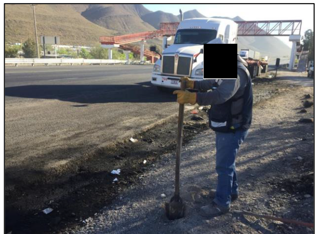
06 - En el suelo natural afectado y en su periferia se llevaron a cabo sondeos a distintas profundidades con el objetivo de conocer la infiltración en el suelo y delimitar la Zona.
