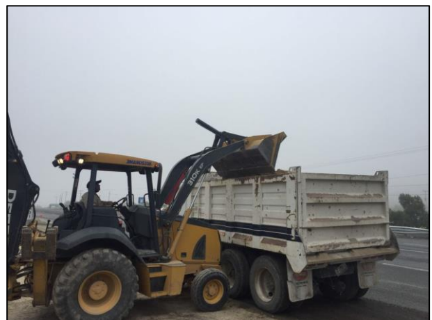
12 - El acarreo del material edáfico que fue extraído se realizó con ayuda de camión de volteo.
