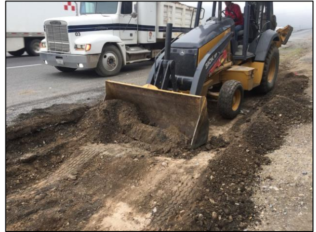
14 - Labor de extracción del material edáfico afectado con Diésel automotriz de la Zona afectada B.
