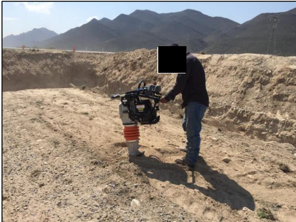
07 - Compactación de la capa de arcilla, utilizando una compactadora manual.
