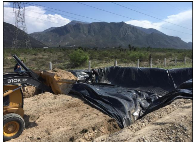
08 - La base de la Celda Provisional, así como sus respectivas canaletas y bordos perimetrales se cubrieron con una película de polietileno de alta densidad.
