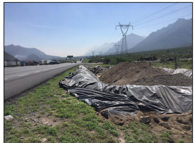
18 - Celda Provisional construida y en la cual se colocó el material edáfico afectado con Diésel automotriz.
