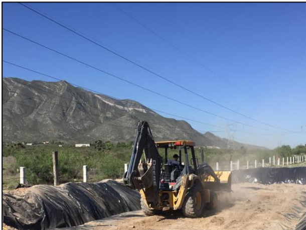
09 - Se llevó a cabo la colocación de una segunda capa de arcilla sobre la base de la Celda Provisional, y se extendió dicha capa de arcilla con ayuda de retroexcavadora.
