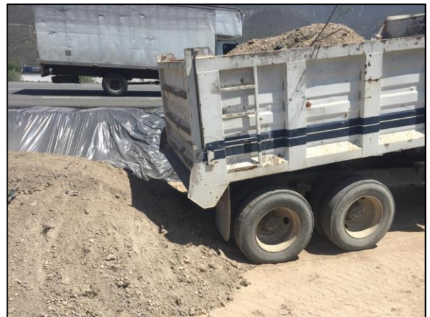
16 - El acarreo y colocación del material edáfico extraído en la Celda Provisional se realizó con ayuda de camión de volteo.
