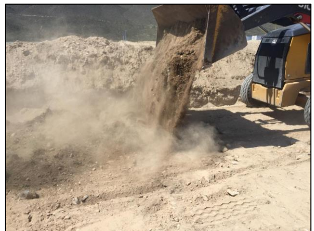
06 - Con apoyo de retroexcavadora se colocó una capa de arcilla en la base de la Celda Provisional.
