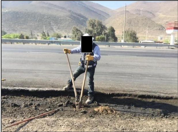
03 - Con el objetivo de conocer la infiltración de Diésel automotriz en el suelo natural afectado se llevaron a cabo sondeos a distintas profundidades.
