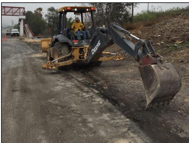
11 - Posteriormente, con ayuda de retroexcavadora se realizó la extracción del material edáfico afectado en el sitio de derrame.
