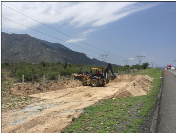
03 - Con apoyo de retroexcavadora se construyeron los bordos de la Celda Provisional.
