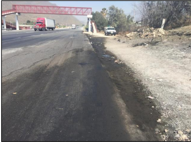
01 - El sitio de derrame en estudio se ubica a la altura del Km. 030 + 600 de la Carretera (2270) Saltillo – Monterrey, tramo Ojo Caliente – Monterrey, municipio de Ramos Arizpe, estado de Coahuila de Zaragoza.
