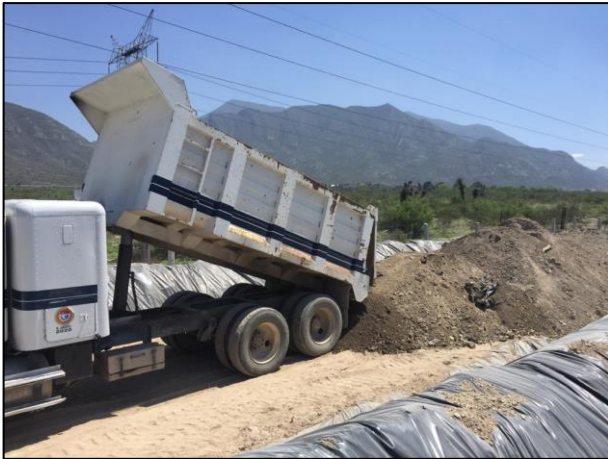
13 - El material edáfico extraído fue depositado en la Celda Provisional.
