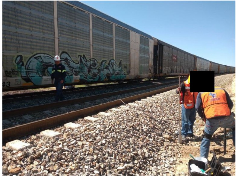
Figura 38. Uso de equipo mecánico-eléctrico para profundizar
