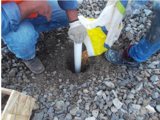
Figura 7-13. Colocación de gravilla es espacio anular del pozo 1
