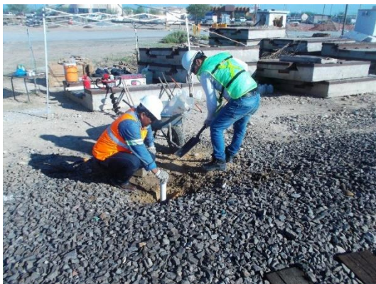
Figura 7-15. Colocación de sello de bentonita en pozo
