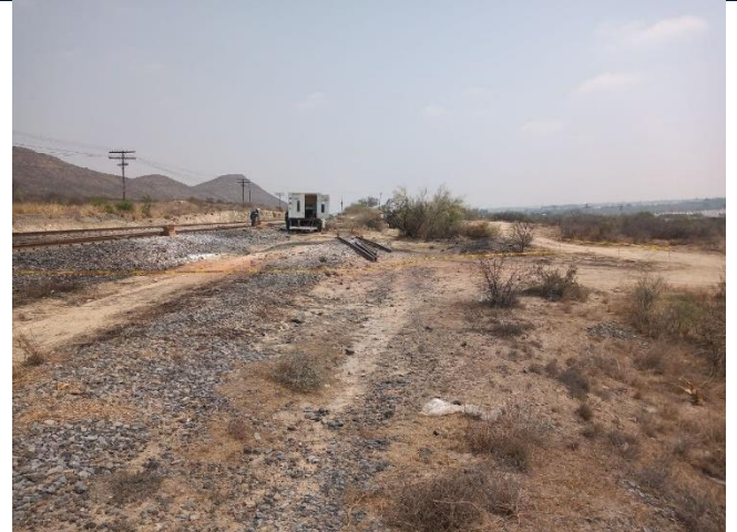
Figura 2. Acotamiento del polígono con cinta precautoria, lado sur
