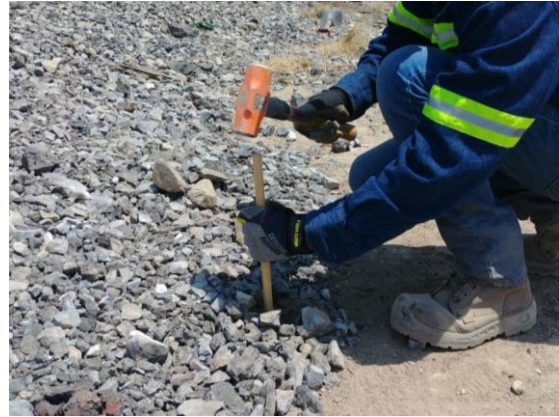
Figura 5.21. Colocación de estaca de madera para señalización de trayectoria
