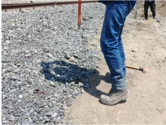
Figura 5.20. Uso de barreta para romper cohesión del suelo
