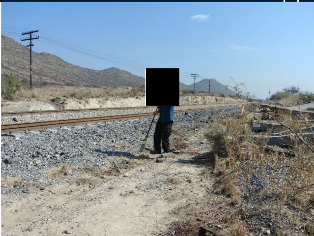
Figura 3. Perforación mecánica manual
