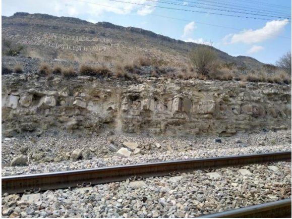
Figura 5.33. Corte donde se observa la interestratificación
