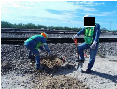
Figura 7-5. Acondicionamiento del punto de perforación con herramienta manual
