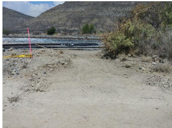
Figura 5.19. Nivelación y limpieza para realizar la trayectoria trazada
