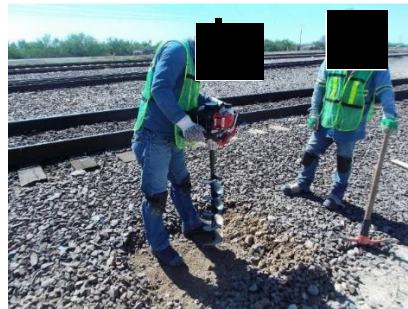
Figura 7-6. Inicio de la perforación con equipo mecánico
