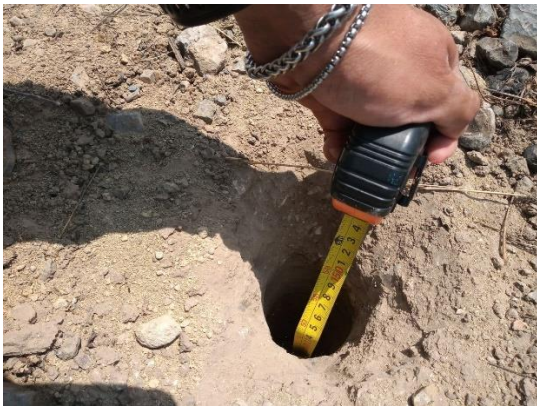
Figura 5.5. Verificación de la profundidad deseada
