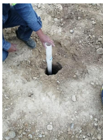
Figura 7-12. Colocación de tubería en perforación para instalación de pozos de bioventeó
