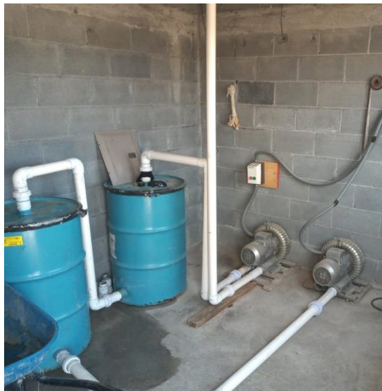
Figura 7-22. Sistema de tratamiento de vapores del suelo
