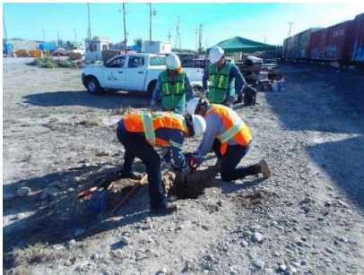
Figura 7-7. Avance de la perforación con equipo mecánico 1
