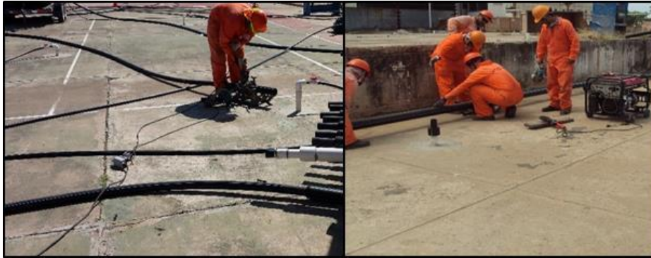
Figura 7-21.- Instalación de ramaleo
