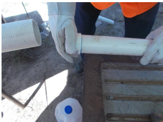
Figura 7-9. Enroscado de tapa con tubería ranurada
