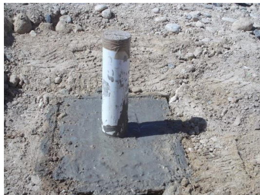
Figura 7-16. Relleno de mezcla de cemento y arena hasta la superficie 1
