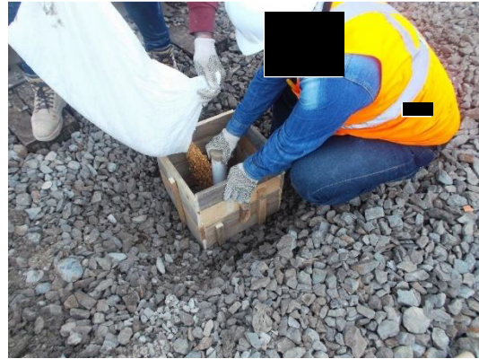
Figura 7-14. Colocación de gravilla es espacio anular del pozo 2
