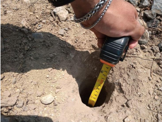
Figura 5. Verificación de profundidad con flexómetro
