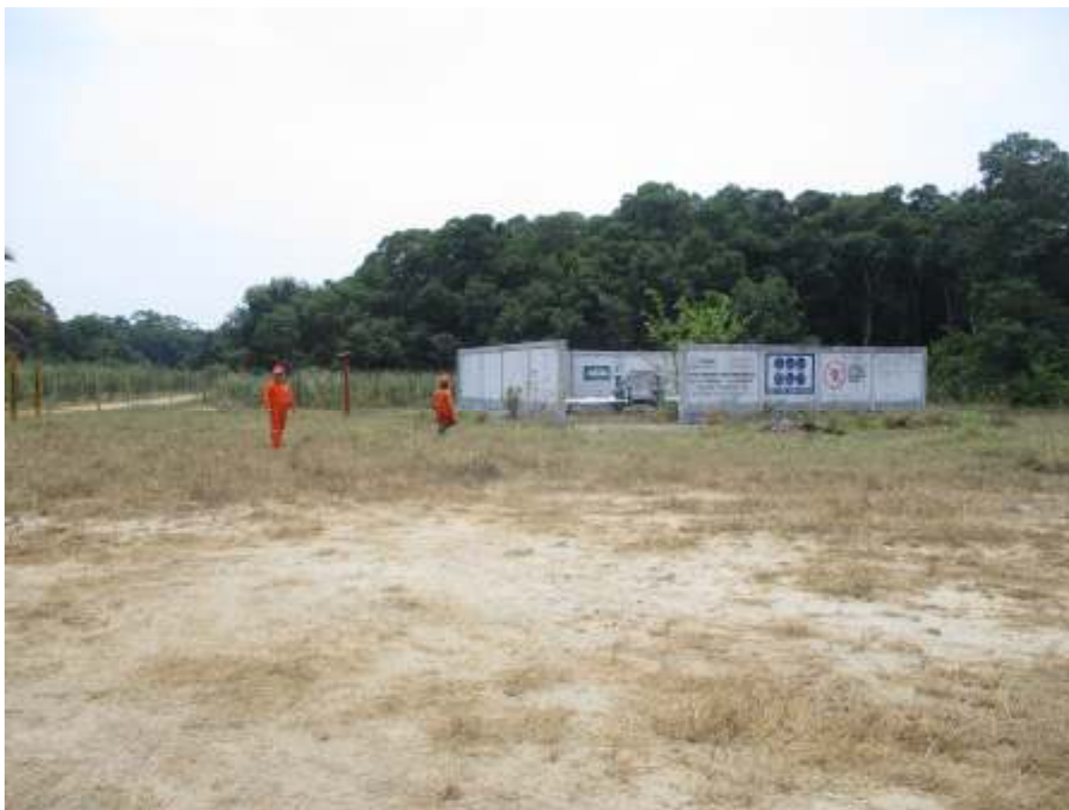
Foto AF-O10X0.3 5. Paisaje predominante en el punto de llegada del oleoducto, km 0+304. La toma Coordenadas de ubicación de la instalación (información reservada). Información protegida bajo los artículos 110 En la parte posterior fracción I de la LFTAIP 113 fracción I de la LGTAIP. de la interconexión se aprecia zona cubierta por vegetación hidrófila enraizada y a una distancia de 30 m aproximadamente una zona de concentración de arbustos y árboles, propias de las zonas inundables (predominando los tulares y pastizales).
