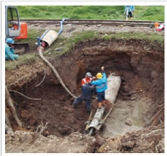
Figura I.10 Proceso de instalación de tubería: perforación e hincado de tubería por golpeo o apisonamiento (pipe ramming)
