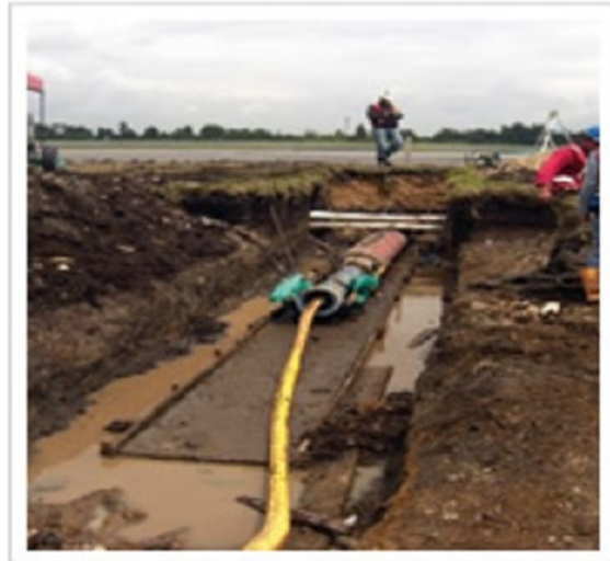
Figura I.10 Proceso de instalación de tubería: perforación e hincado de tubería por golpeo o apisonamiento (pipe ramming)
