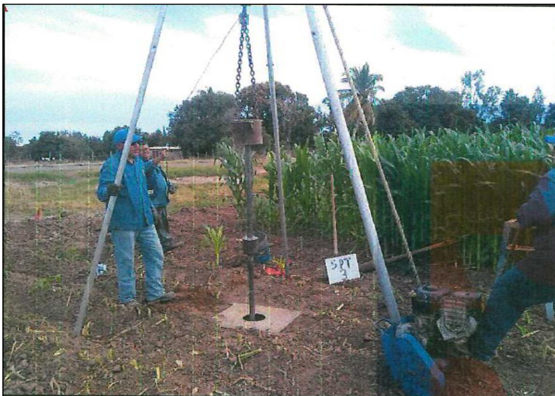
Fotografía 13. Vista de la realización del SPT #3.
