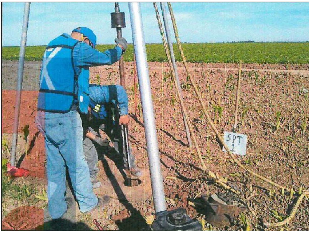
Fotografía 9. Vista de la realización del SPT #1.
