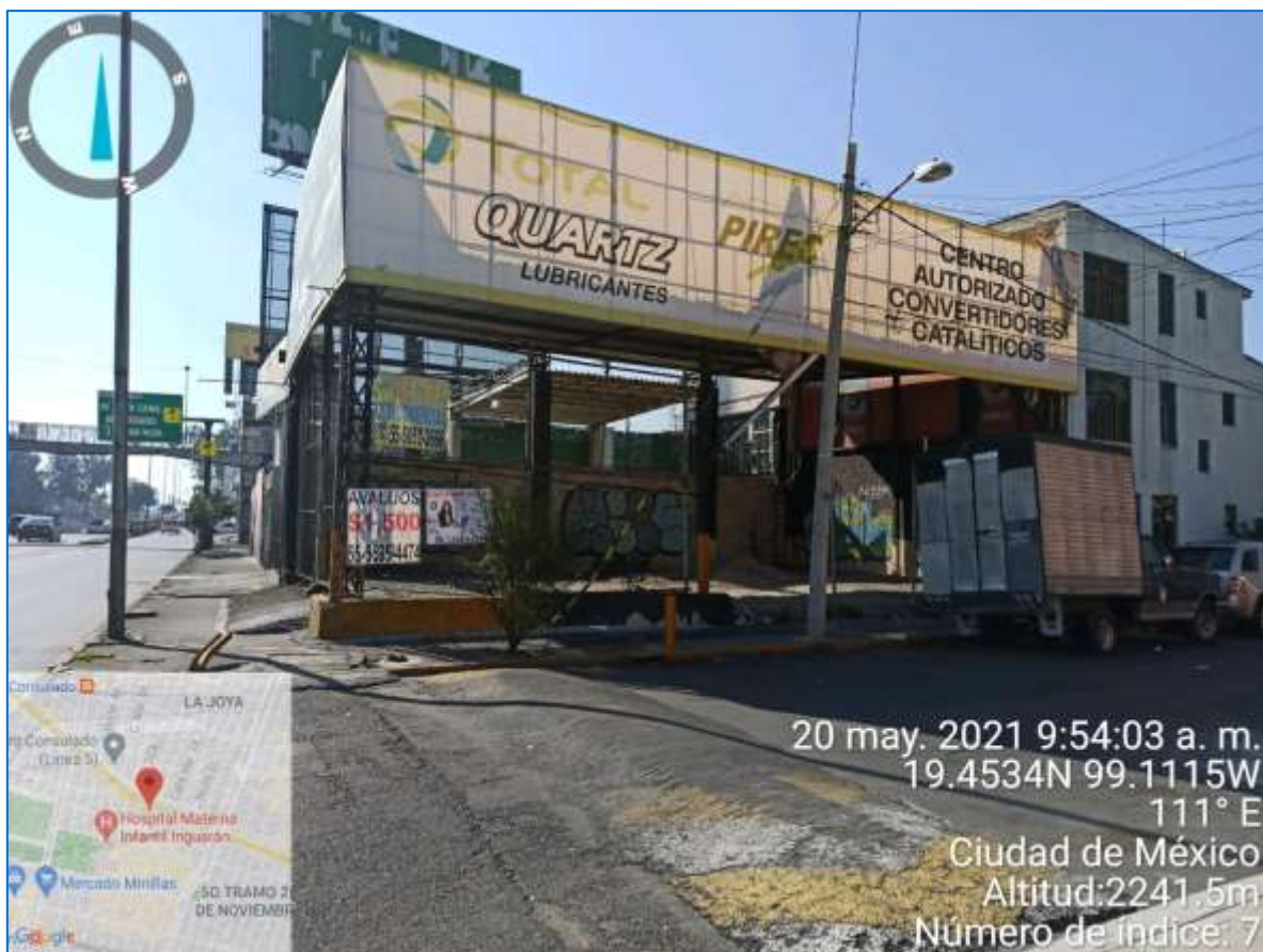
Figura 31 Vista del frente del área del proyecto
