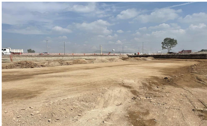
Condiciones del predio destinado para la estación de servicio
