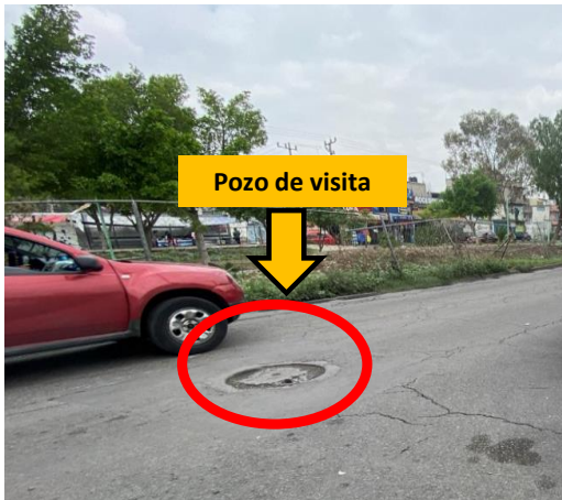
Foto 7- Pozo de visita sobre calle Valle de Guadiana.
