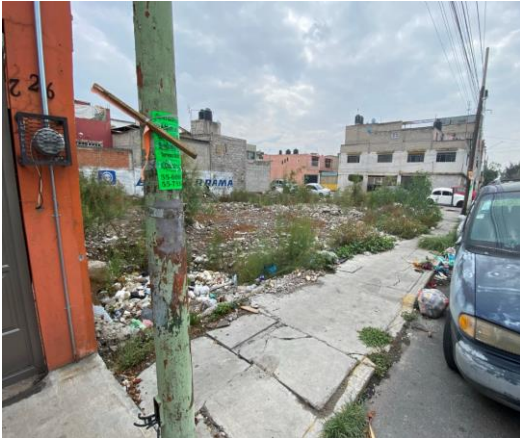
Foto 4- Colindancia Sur, sobre calle Valle de Guadiana. Vista con dirección al Oriente.
