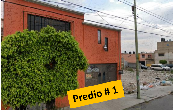
Foto 1- La casa habitación color naranja del Predio # 1 será demolida. Colindancia Sur con vista en dirección al Sureste, sobre calle Valle de Guadiana.
