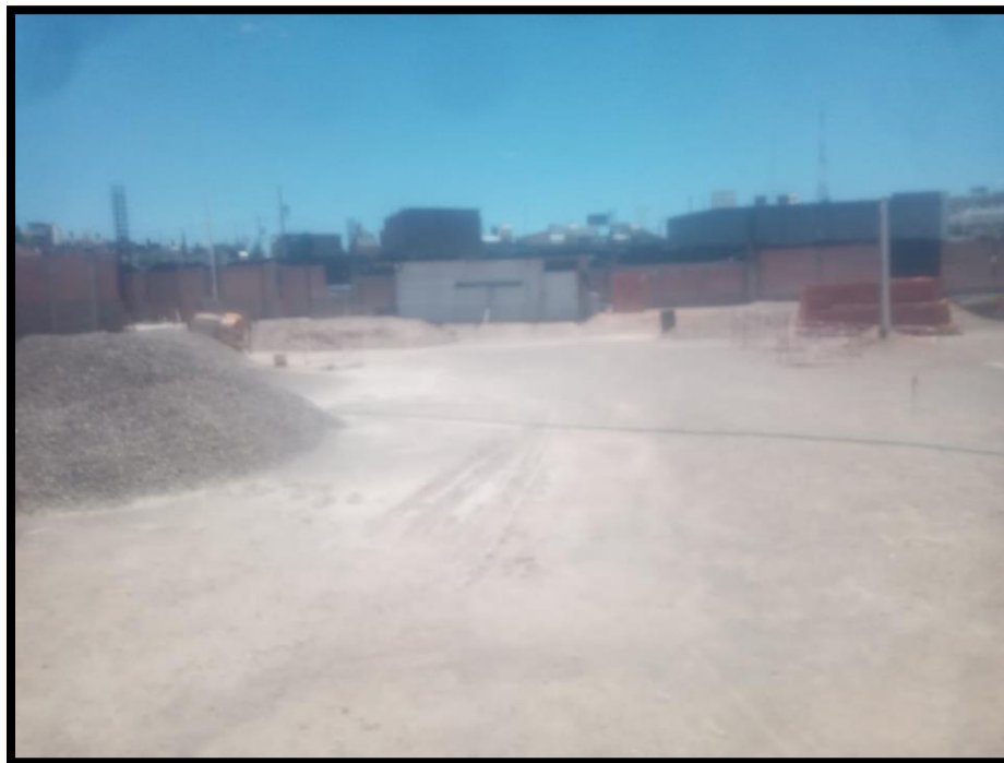
Foto 2: Vista Sur de la obra
