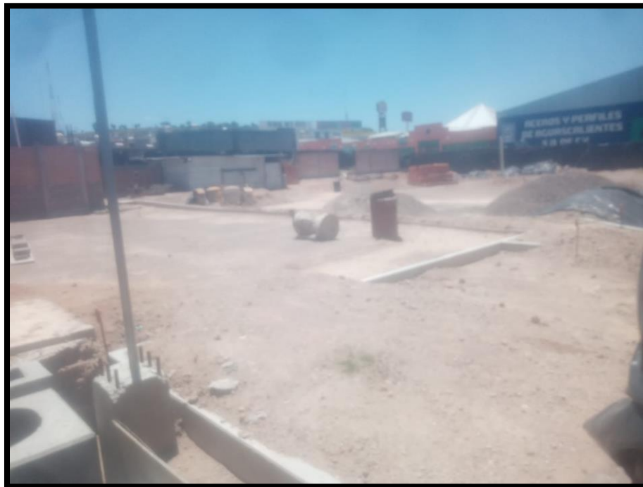
Foto 3: Vista suroeste del proyecto
