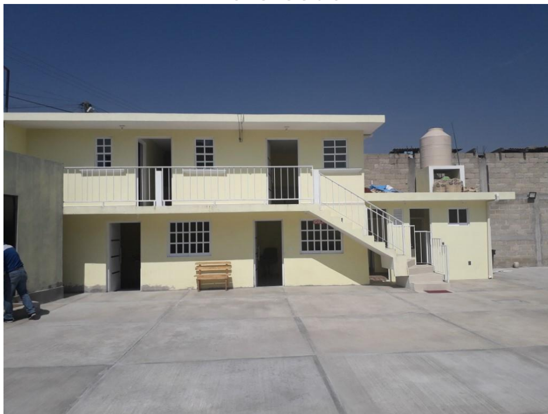
Ilustración 24 Área de edificios del proyecto
