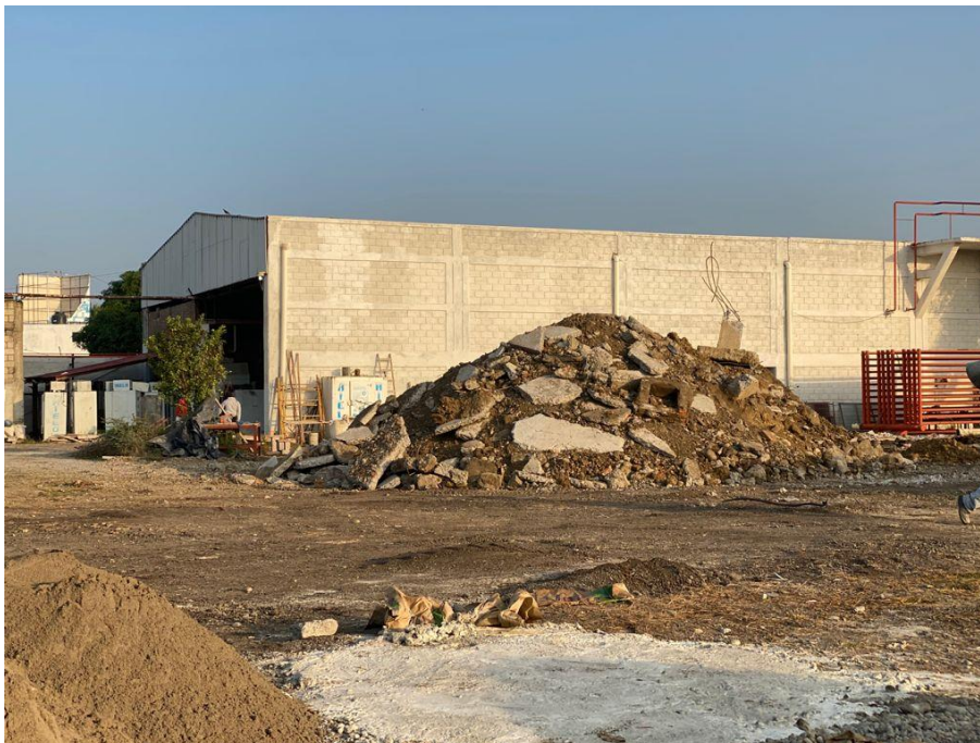
Imagen 10. Vista central del predio, se observa el material depositado y al fondo la fábrica de hielo que no forma parte del predio.
