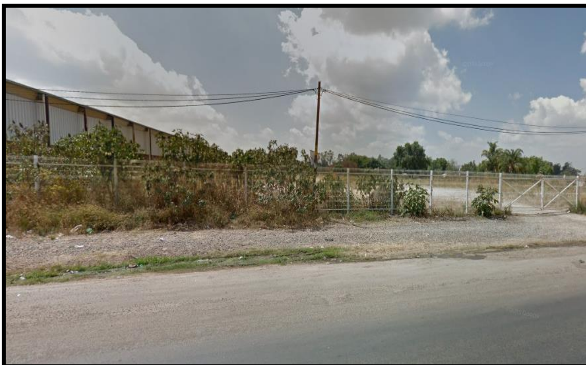
FOTOGRAFÍA 31. IMPORPAQ A 187.97 METROS LINEALES AL OESTE.
