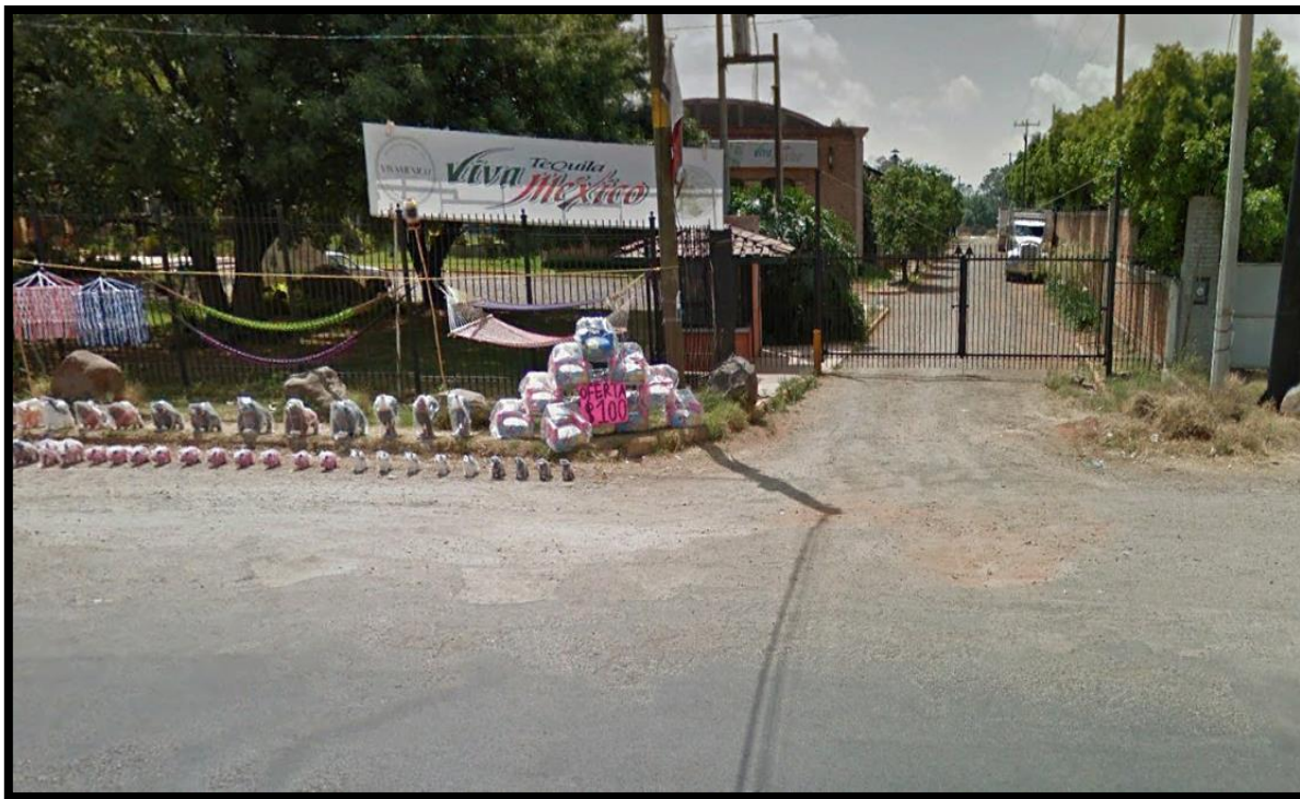
FOTOGRAFÍA 28. FÁBRICA DE TEQUILA A 95.03 METROS LINEALES AL SUROESTE.
