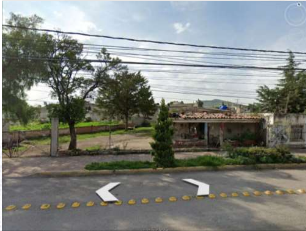
Fotografía 4. Construcción abandonada que forma parte de predio para el proyecto de Preparación del sitio, construcción, operación y mantenimiento de la Estación de Servicio: LUNA GAS, S.A. DE C.V. También se observa arbolado urbano que será derribado durante las etapas de preparación del sitio y construcción.
