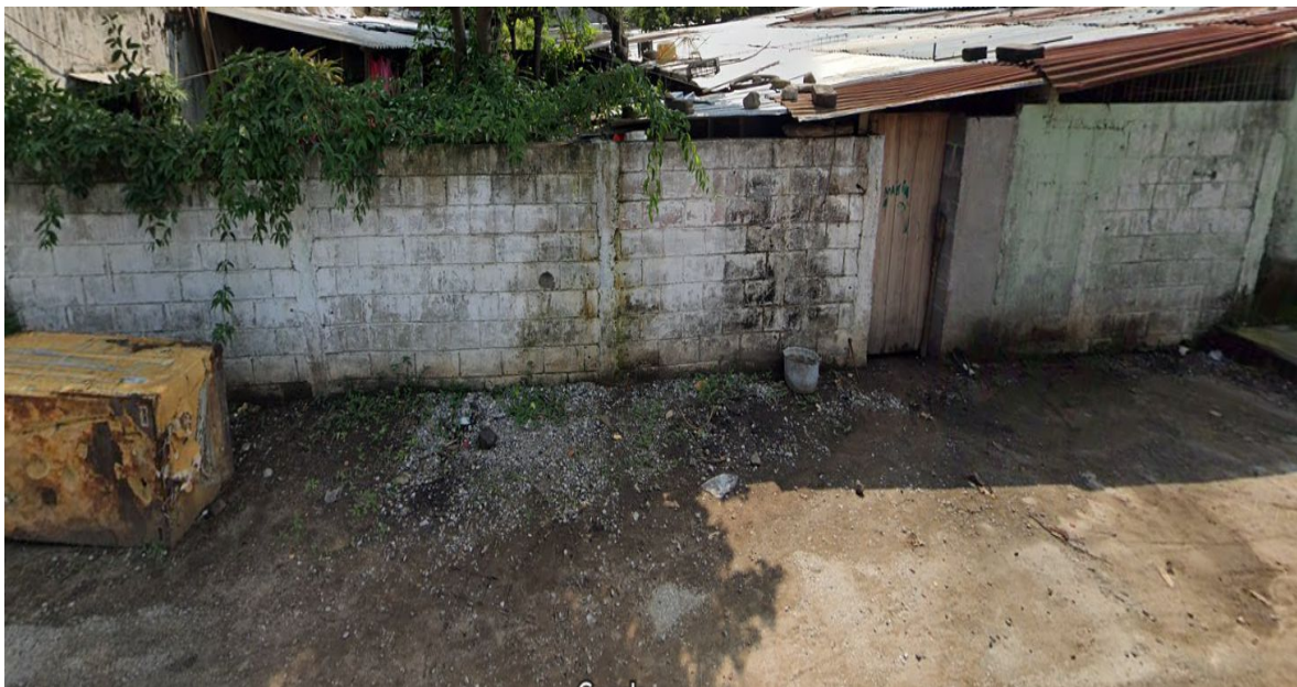
Vista interior hacia el Poniente Construcción dentro del predio que fungía como vivienda del velador.
