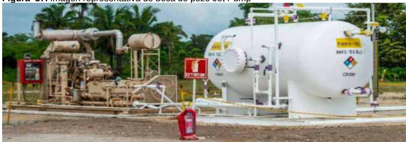
Figura 37. Imagen representativa de boca de pozo Jet Pump
