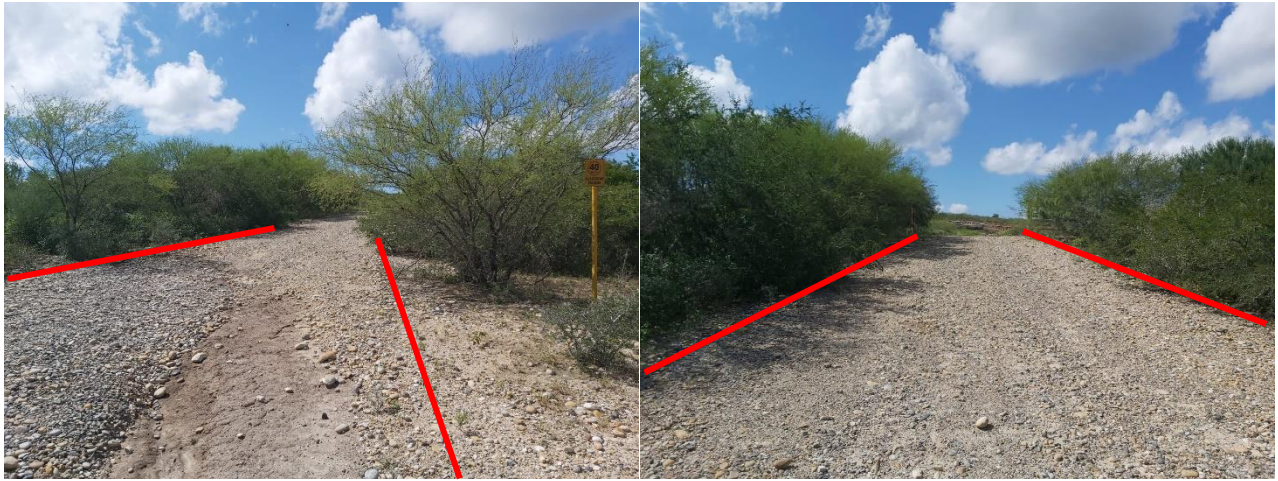
Figura 43 Se observa el camino de acceso al Pozo existente Granaditas 7, donde se localizara el Pozo Granaditas-12 DES.
