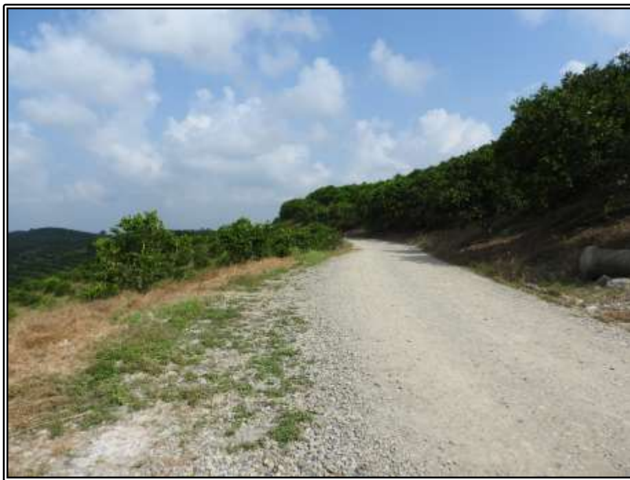
Fotografía I.1.1-3.- Camino de acceso existente de la plataforma de los pozos MIQUETLA-52, MIQUETLA-865 y MIQUETLA-847.
