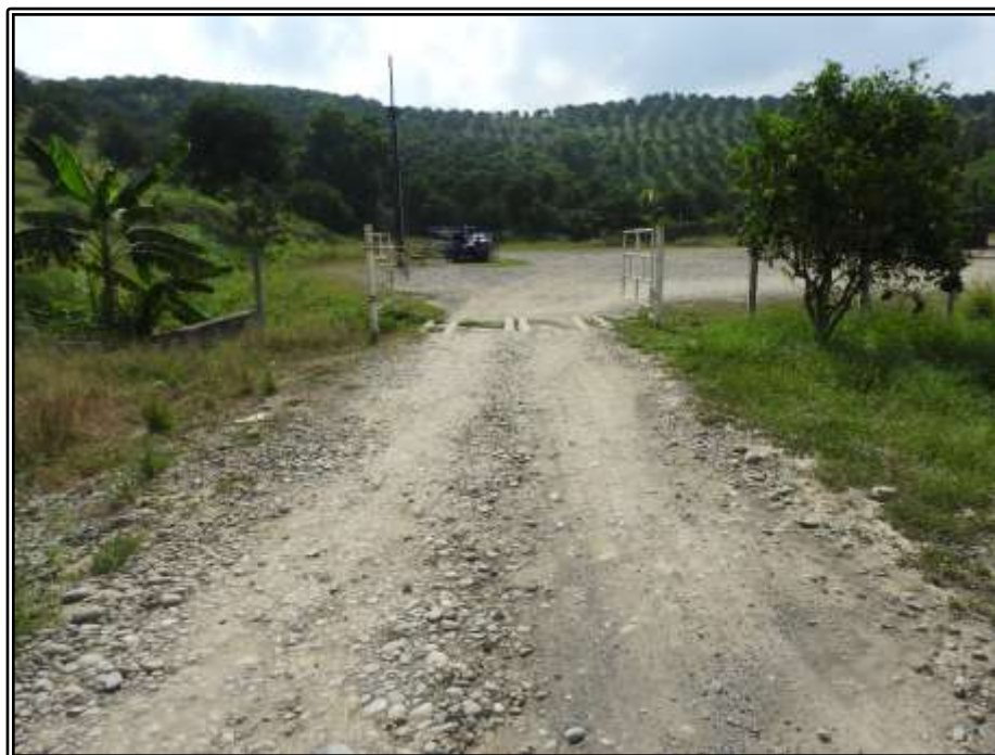
Fotografía I.1.1-2.- Plataforma del pozo existente MIQUETLA-52, MIQUETLA-865 y MIQUETLA-847, vista desde el acceso a la plataforma.
