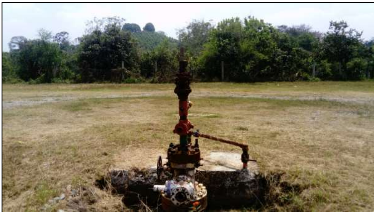
Fotografía III.4.6-1.- Plataforma existente donde se pretende realizar la ampliación para perforar el pozo INFILL-7.
