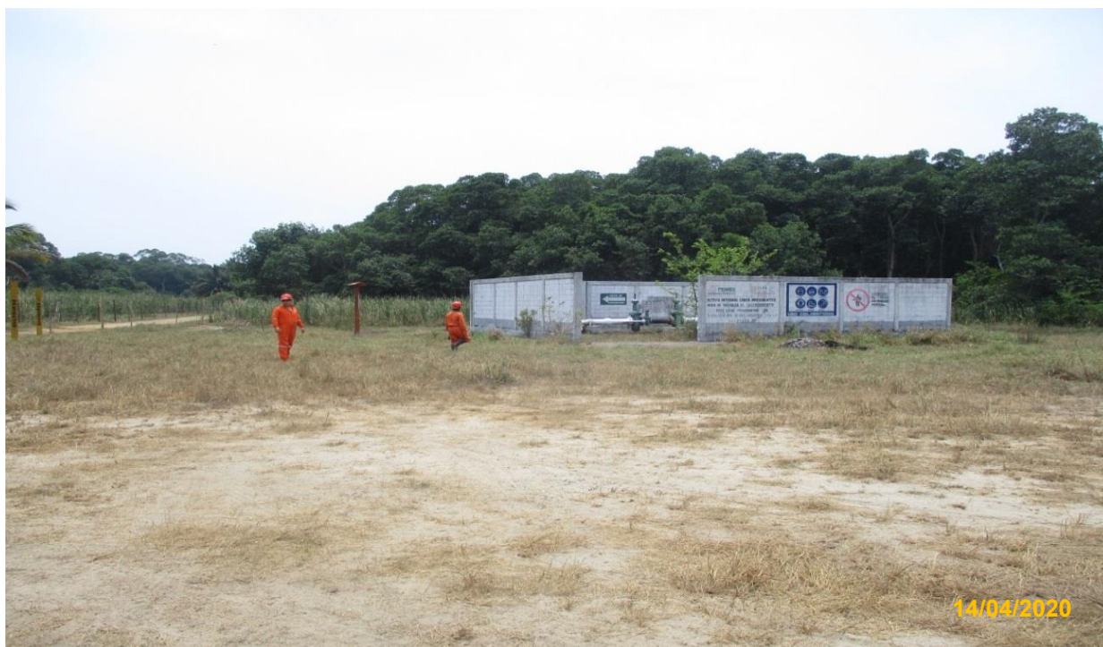
Foto VIII.49. Fotografía del paisaje en el trazo del proyecto de “Construcción de Oleoducto de 10” Ø x 0.309405 Km de la Batería de Separación Cinco Presidentes 2 a la Interconexión con Oleoducto de 10” Ø " Rodador-CPGLV" en el Km 0+304 tomada en dirección s
