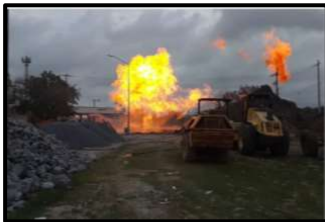
Foto 4. Explosión causada por maquinaria.
