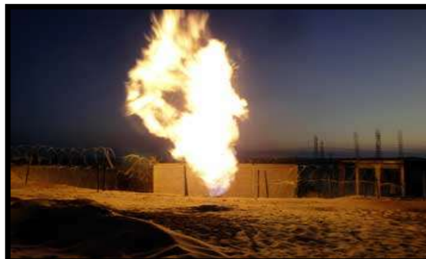
Foto 5. Chorro de fuego a causa de la fuga de gas natural en el municipio de Huimanguillo, Tabasco.
