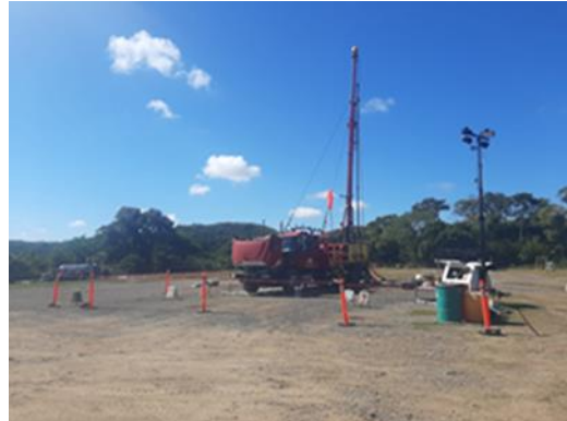
Registro Fotográfico No 15. Instalación de unidad de swab, para realizar actividad de calibración de equipo de control de presión y viajes de inducción mecánica, en pozo La Laja 11DEL.
