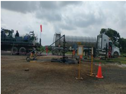
Registro Fotográfico No 12. Actividad de bombeo de sistema orgánico para circulación del pozo la Laja 11DEL.
