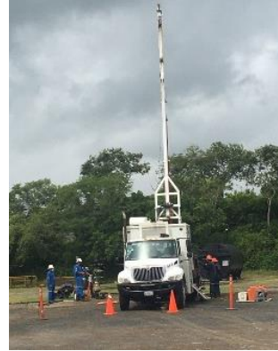
Registro Fotográfico No 5. Actividad operativa con unidad línea de acero para realizar calibración de tubería y colocación de tapón PX en pozo Laja 11DEL.
