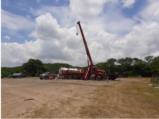
Registro Fotográfico No 1. Actividad operativa de recuperación de sarta de velocidad (50 mts) en el Pozo La Laja 11DEL.
