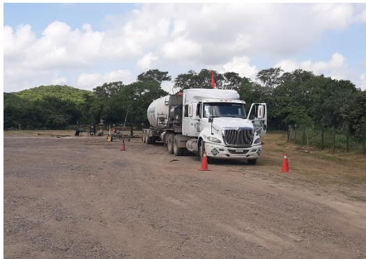
Registro Fotográfico No 3. Actividad operativa de inducción de N2 en el Pozo La Laja 11DEL.
