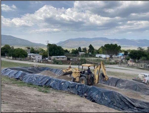
7. Colocación de segunda capa de arcilla con apoyo de retroexcavadora.
