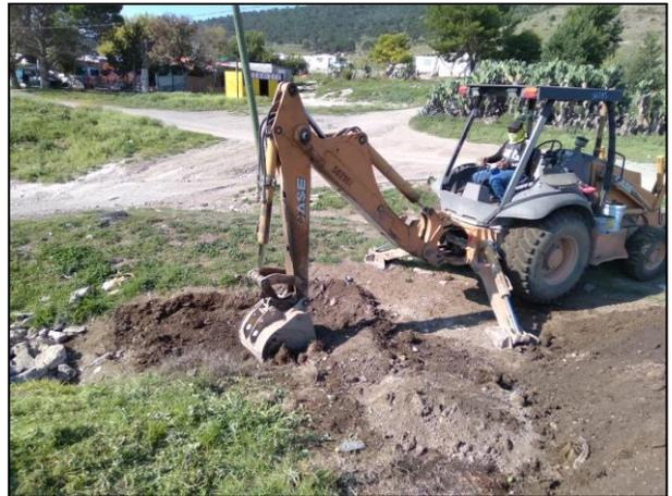
10. Extracción del material edáfico afectado con apoyo de retroexcavadora.
