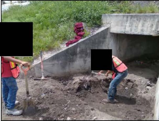
13. Con apoyo de recurso humano, se realizó la extracción del material edáfico azolvado en el paso subterráneo de concreto, afectado por el derrame de Diésel.
