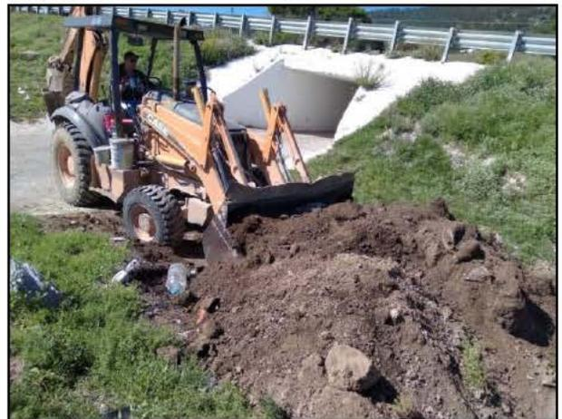
16. Con apoyo de retroexcavadora se extrajo el material edáfico afectado por Diésel.
