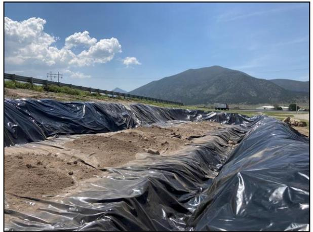
6. A la base de la Celda se le colocó una película de polietileno de alta densidad.
