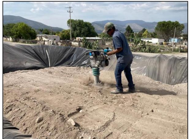
8. Con apoyo de recurso humano y de un v bro compactador manual, se realizó la compactación de la capa de arcilla.
