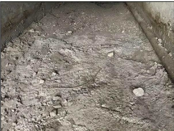
29. Se extrajo el material edáfico azolvado, encontrado en la alcantarilla de concreto, quedando sobre base de concreto al finalizar la limpieza.
