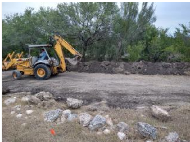
01. Se llevó a cabo la nivelación del terreno en el que se construyó la Celda provisional.
