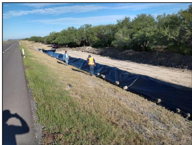
05. Los bordos de la Celda Provisional se cubrieron con película de polietileno de alta densidad.
