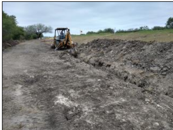
02. Adecuación de los bordos para la Celda Provisional.
