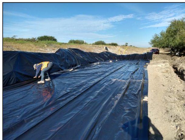
06. De igual manera la base de la Celda Provisional fue cubierta con película de polietileno de alta densidad.
