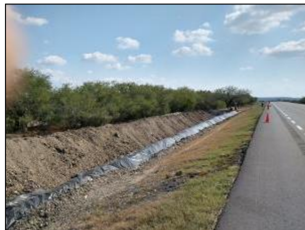
12. Vista final de la Celda Provisional.
