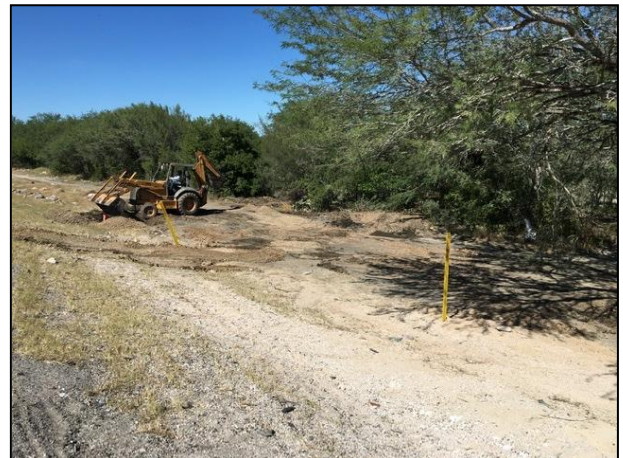
05. Se realizaron sondeos en el área afectada a fin de determinar la pluma del contaminante.
