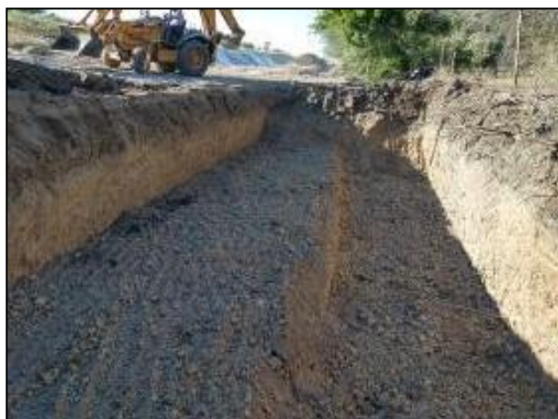
11. Fosas de Excavación resultante de las labores de Extracción en el sitio.
