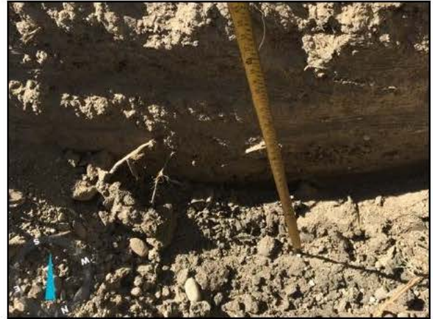
07. Con apoyo de flexómetro se corroboró la infiltración del hidrocarburo derramado.
