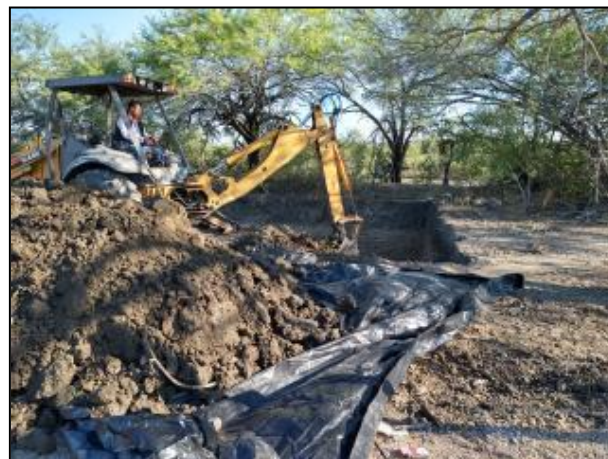
10. Extracción del material edáfico afectado, mismo que fue depositado en película de polietileno de alta densidad para su posterior acarreo a la Celda Provisional.
