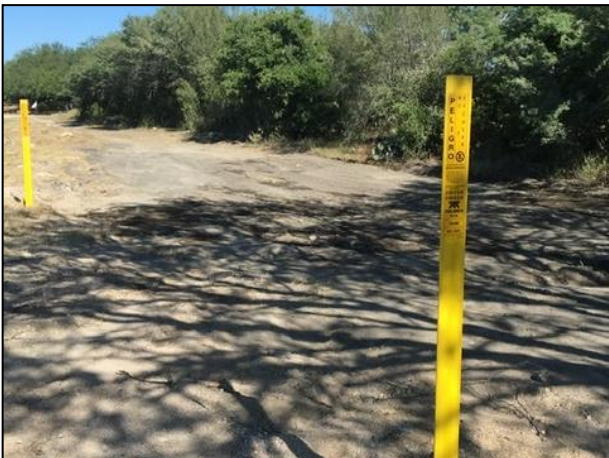
04. En el sitio se observa la presencia de postería de fibra óptica de TELMEX.
