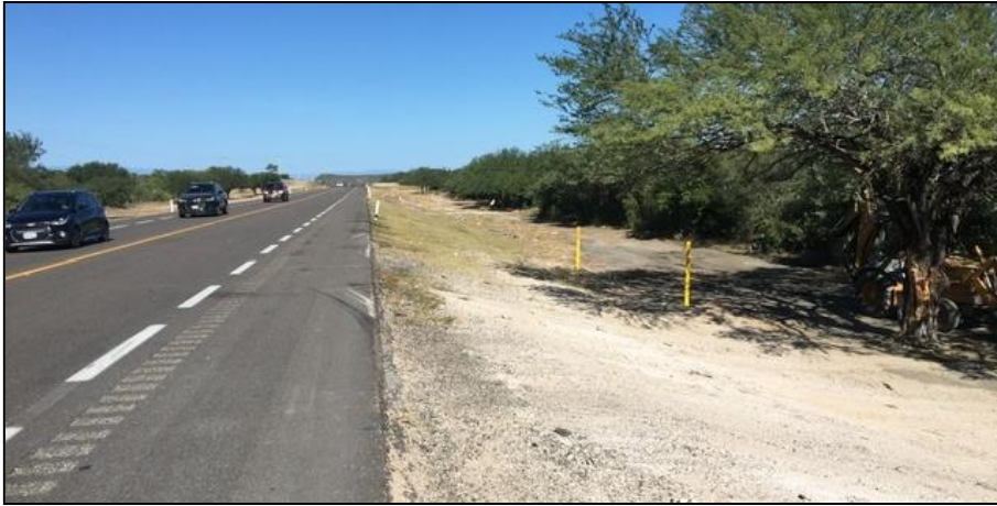
01. El sitio en estudio se encuentra en el Km. 34 de la Carretera González – Zaragoza, municipio de González, estado de Tamaulipas.
