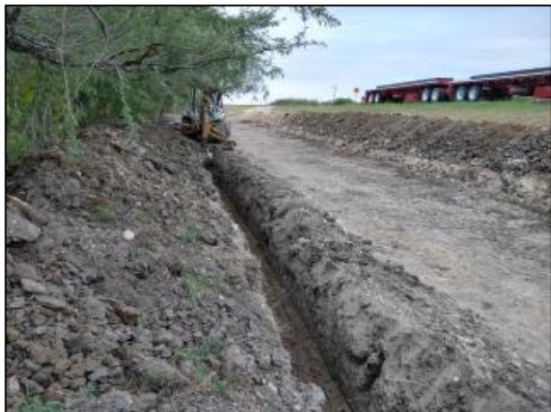
03. Construcción de canaleta para Celda Provisional.
