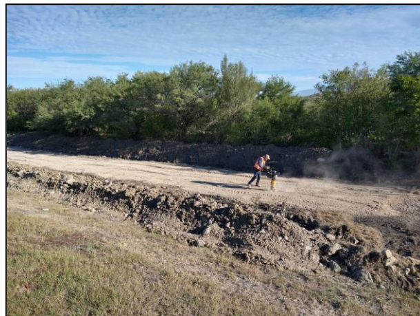
04. La base de la Celda se construyó con una capa de arcilla.
