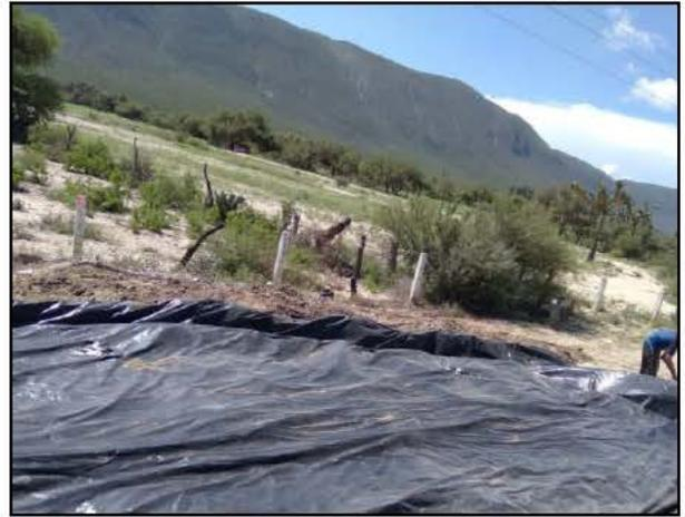
02. El área afectada fue cubierta en su totalidad con película de polietileno de alta densidad para evitar la transferencia suelo – atmósfera del hidrocarburo derramado.
