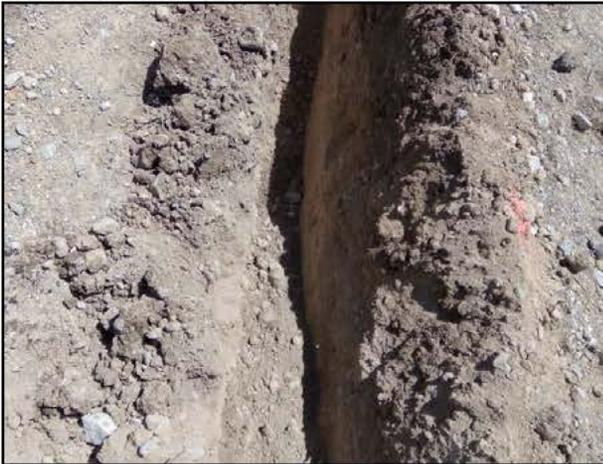
01. El sitio fue debidamente acondicionado para realizar la barrera de contención, a fin de evitar el desplazamiento horizontal del hidrocarburo.
