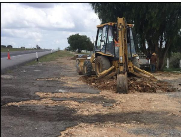
11 - Labor de extracción del material edáfico afectado por el derrame de Turbosina.
