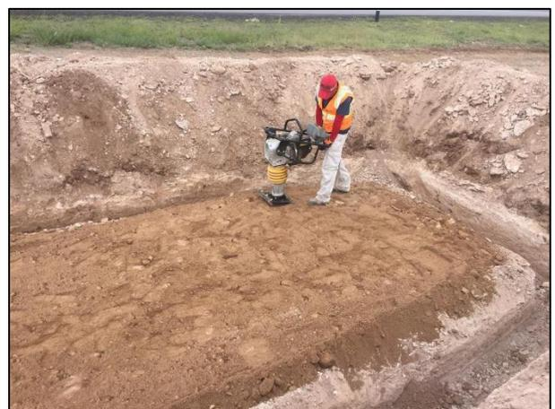
06 - Compactación de la capa de arcilla, utilizando una compactadora manual.
