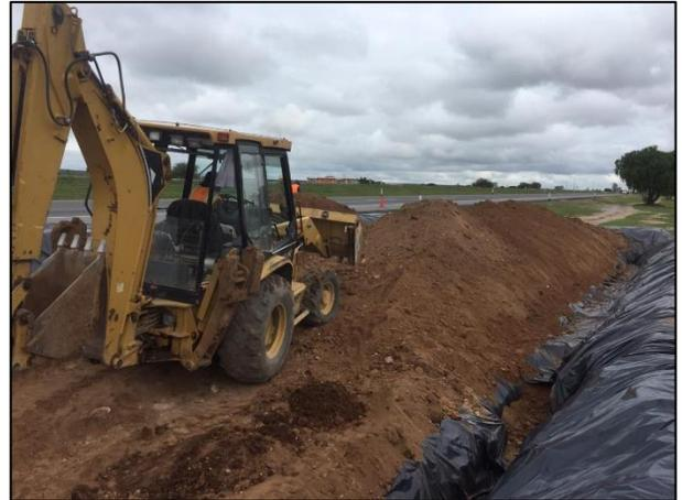
14 - Depósito del material edáfico afectado por el derrame de Turbosina.
