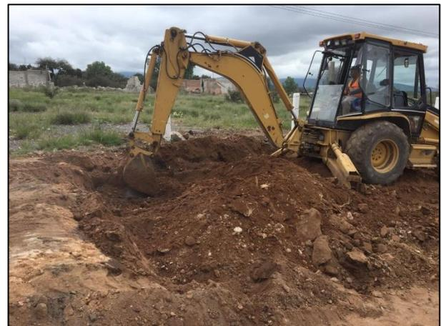
10 - Con ayuda de retroexcavadora, se realizó la extracción del material edáfico afectado en el sitio de derrame.
