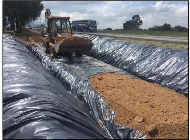
08 - Colocación de segunda capa de arcilla sobre la base de la Celda Provisional.
