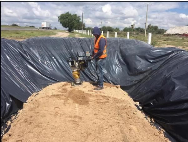
09 - Con apoyo de recurso humano y de una compactadora manual, se realizó la compactación de la capa de arcilla.
