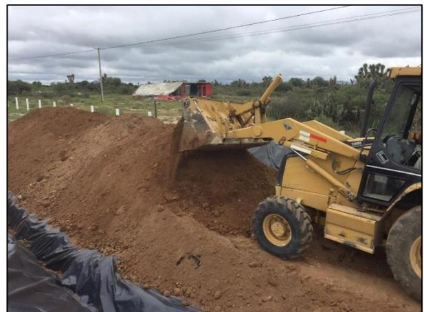
12 - El material edáfico extraído fue depositado en la Celda Provisional.
