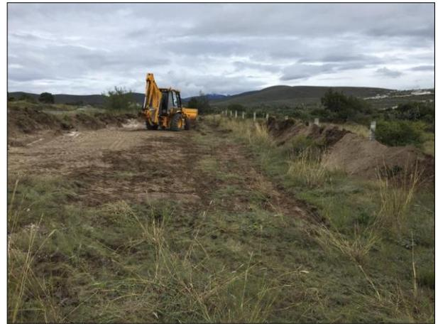
02. Se llevó a cabo la nivelación del terreno en el que se construyó la Celda Provisional.
