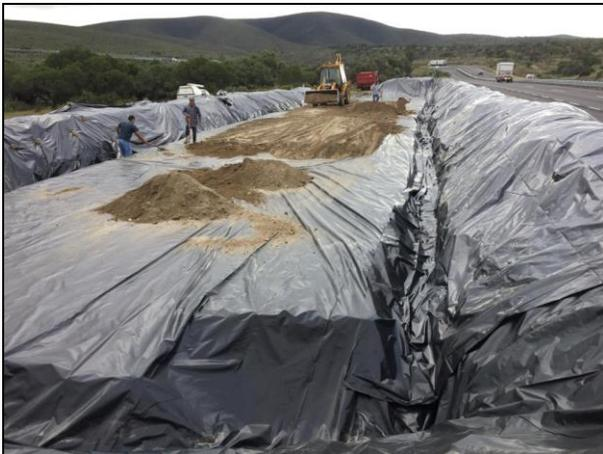
09. Depósito de segunda capa de arcilla sobre película de polietileno de alta densidad
