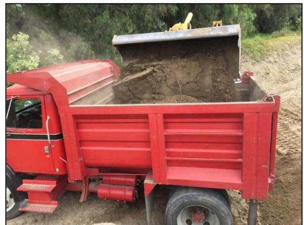
12. Extracción del material edáfico afectado, mismo que fue depositado en camión de volteo para su posterior acarreo a la Celda Provisional.
