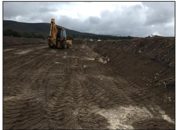
06. La base de la Celda se construyó con una capa de arcilla.
