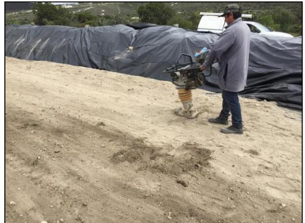
10. Compactación de la segunda capa de arcilla depositada en la Celda Provisional.
