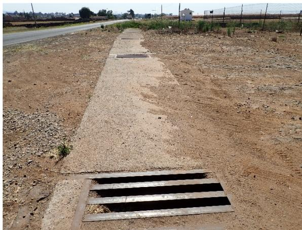
Figura 17. Aspectos de la alcantarilla pluvial existente ubicada en el límite oriente del predio, la cual previene de encharcimientos al predio que ocupará la planta de distribución.
