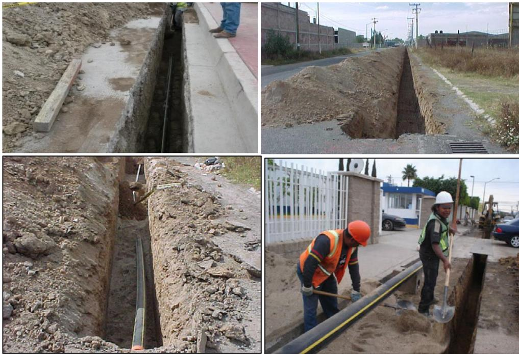
Figura II.42. Fotografía ilustrativa Preparación del fondo de Zanja y colocación de cama de arena
