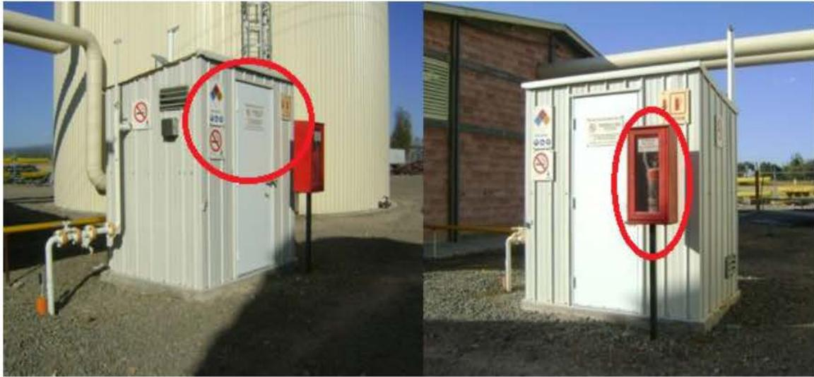
Figura II.32. Ejemplo de colocación de extintor y señalamientos de seguridad
