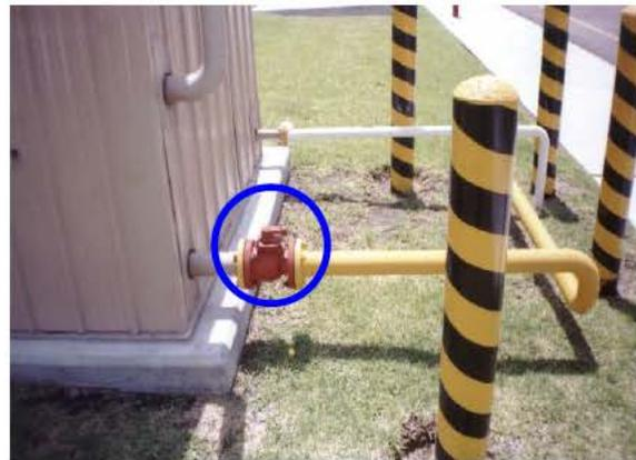
Figura II.33. Ejemplo de brida donde termina la construcción responsabilidad de Consumidora Industrial Otay
