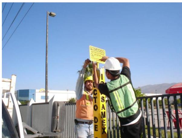
Figura II.55. Fotografía ilustrativa de colocación de poste de señalización tipo, de concreto armado.
