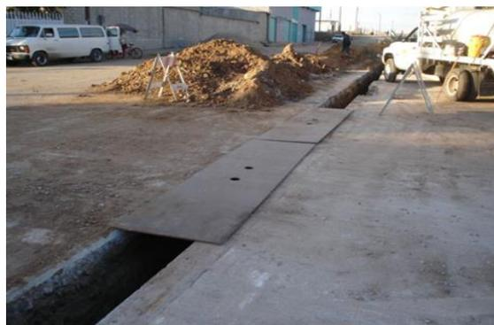
Figura II.36. Excavación de la zanja para el gasoducto e instalación de placas para paso
