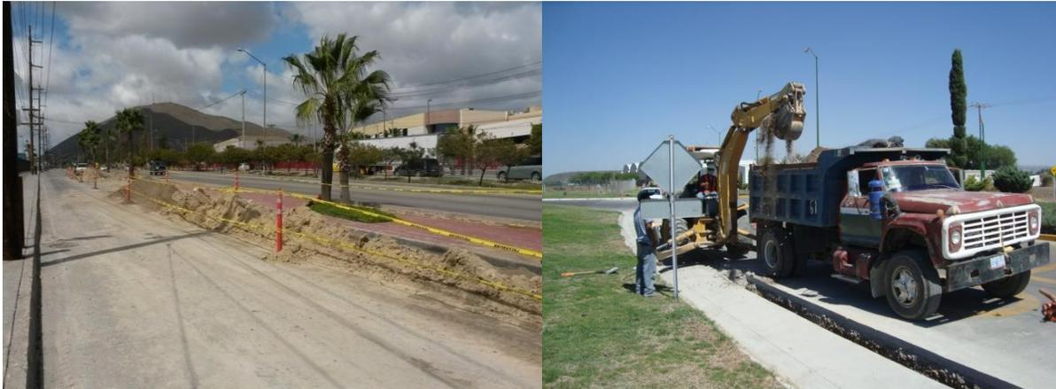
Figura II.37 Ejemplo de retiro de material de excavación
