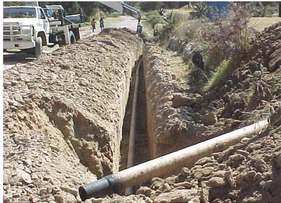
Figura II.43. Fotografía ilustrativa Bajado de tubería
