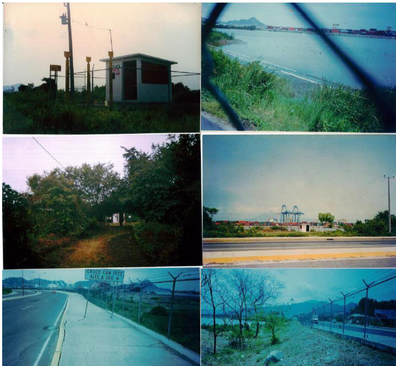
Figura IV-31 Imágenes del derecho de vía del Poliducto de 24" Ø RASP-TAD Manzanillo del km 4+216 al km 4+720, donde se observa que no existía mangle
