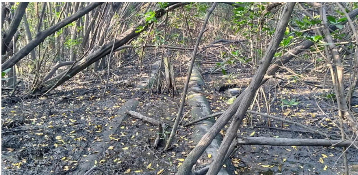
Ilustración II-1 Condición del sitio a desarrollar la actividad de mantenimiento del Poliducto de 24" D.N.
