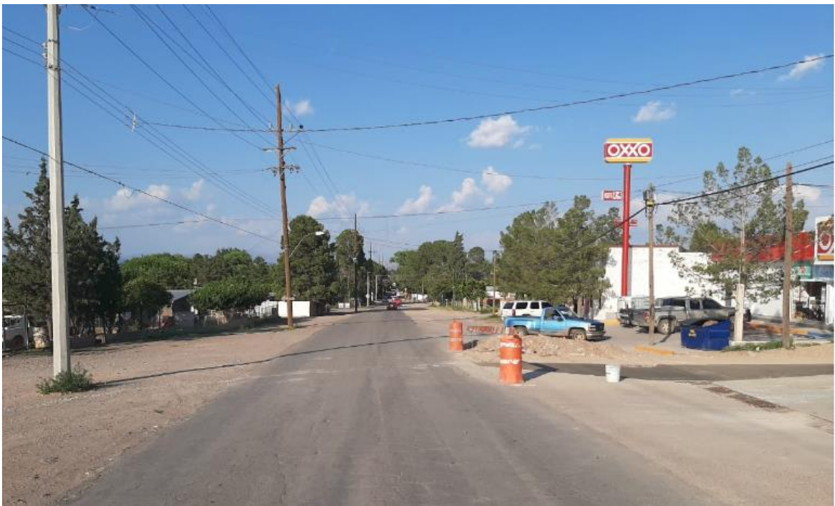
Imagen 13. Fotografía tomada al Este con respecto del sitio de proyecto sobre la Avenida Benito Juárez. Al lado derecho tienda de cadena comercial Oxxo. En la imagen se aprecia actividad de mantenimiento de la red de drenaje, potería de servicio de telefonía, energía eléctrica habitacional y de alta tensión.
