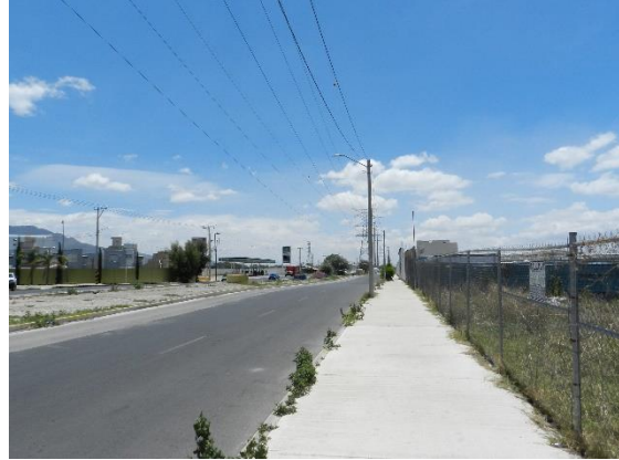
Se observa que el predio se localiza a 52 m de distancia de los cables de alta tensión considerando que la NOM-005-ASEA-2016 marca una distancia mínima de 30m tomando como referencia la ubicación de los tanques
