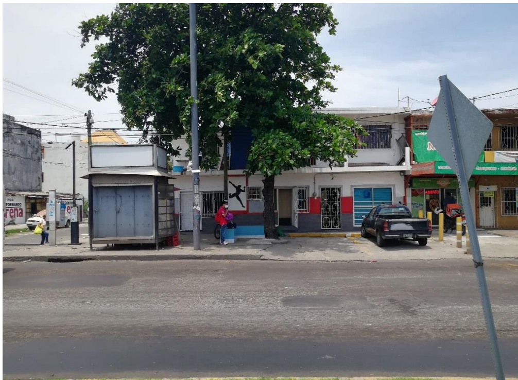
Fig. 50 Instalaciones del Límite noroeste del predio de la Estación de Servicio.
