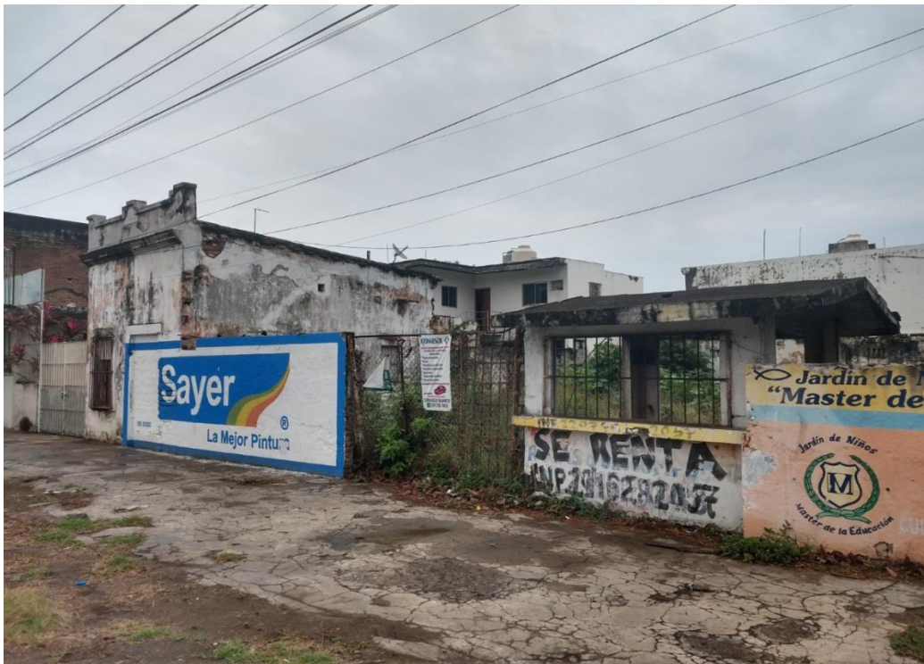
Fig. 6 Vista actual del predio sin la estación de servicio.
