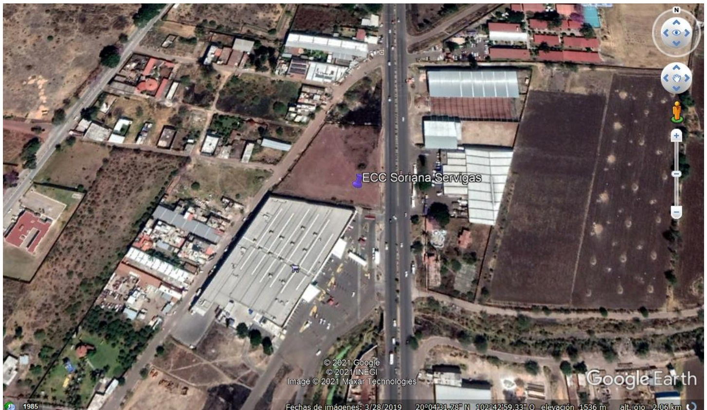
Figura 1.- Ubicación de la instalación
