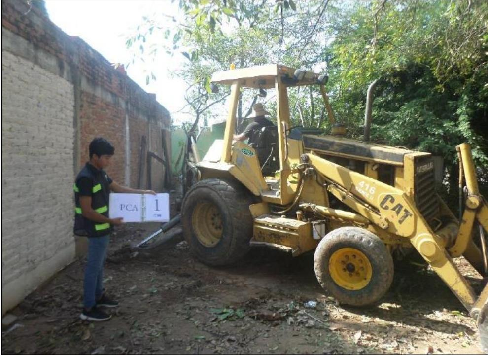
Fotografía 7. Realización del Pozo a Cielo Abierto PCA #1.
