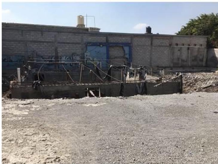
6. Ahora se ve la fosa de tanques en construcción. En la esquina de la derecha se construirá el edificio de oficinas.
