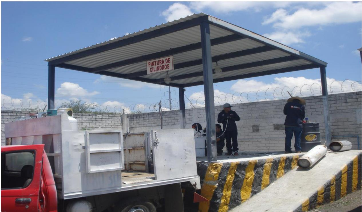
**Fotos 7 y 8.** Se observa cubeto de retención de diésel para consumo de tracto camiones con sus medidas de seguridad, propiedad de la empresa, delimitada mediante muretes de concreto, fuera de la zona de almacenamiento, anden de llenado de cilindros portátiles, así como tomas de suministro y toma de carburación de auto consumo e isla para hidrante.
