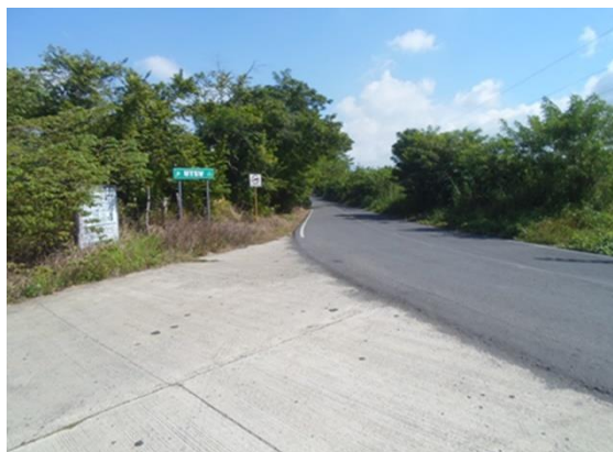
Fotografía V.1.Carretera pavimentada Paso Nuevo-Ixhuatlán de sureste, entronque a villa del Espíritu Santo.
