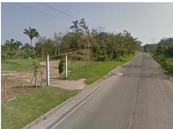
Fotografía V. 5 Carretera pavimentada Paso Nuevo-Ixhuatlán de Sureste al área 400.
