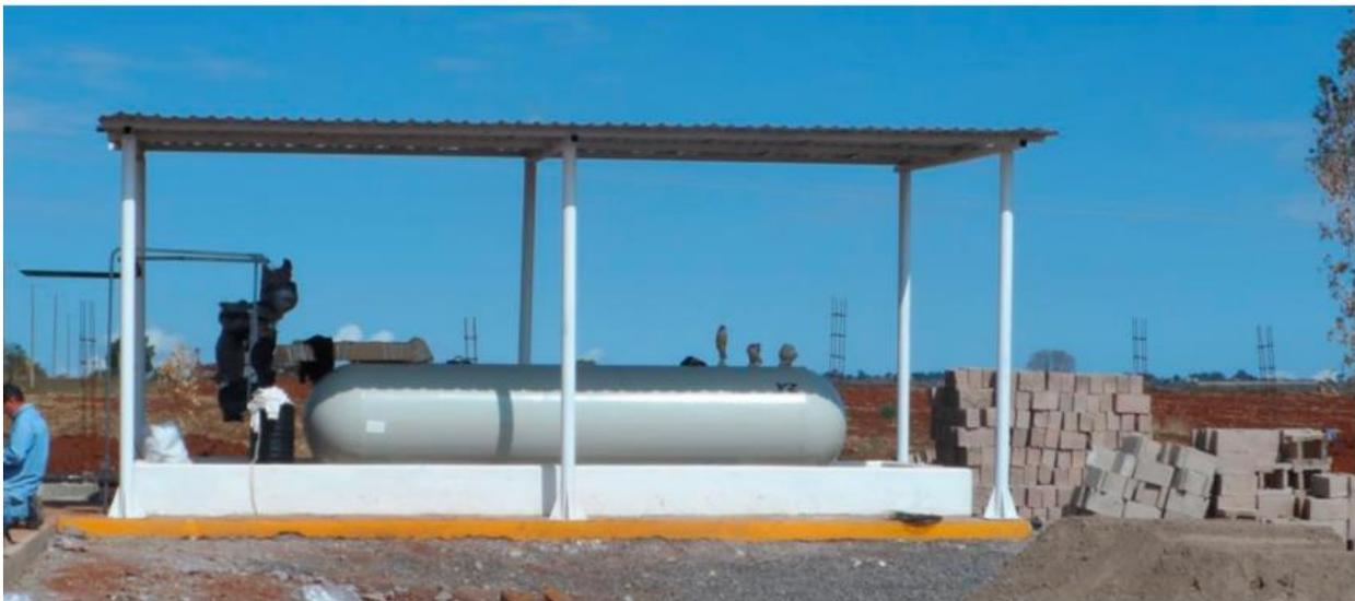
**Figura I-16. Ejemplo de Sistema de Odorización**
